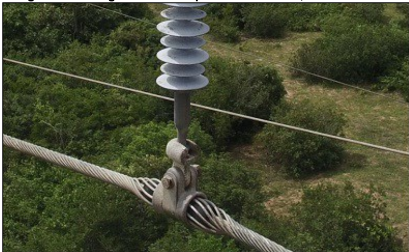
Figura 26 - Imagem coletada por um VANT a 1,5m do isolador.
