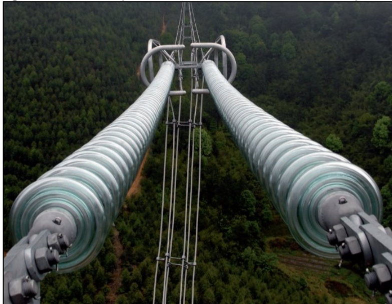
Figura 4 – Isolador para LT de alta tensão em Vidro Temperado
