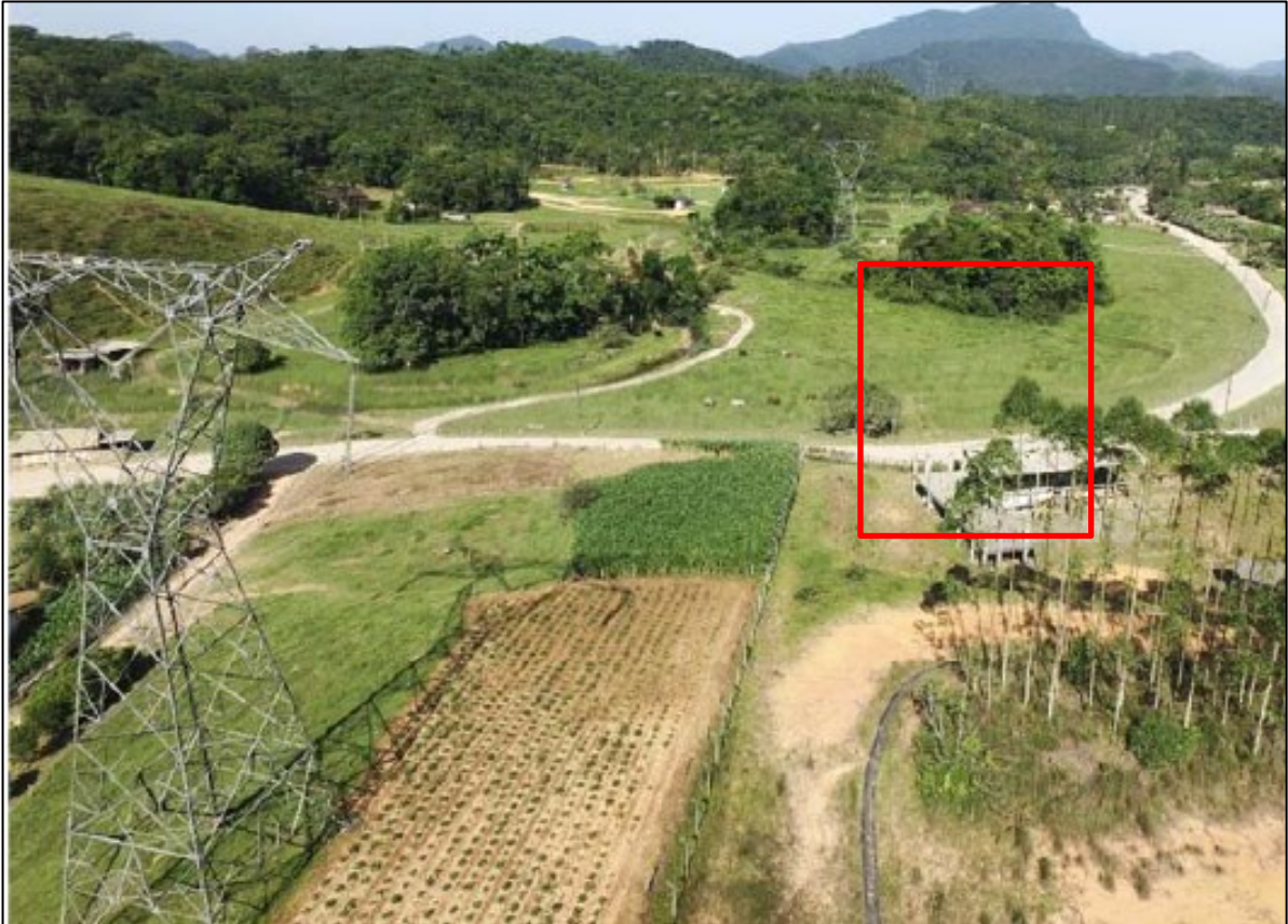
Figura 19 - Uso da faixa de servidão para lavouras com plantação de eucaliptos próximo a LT
