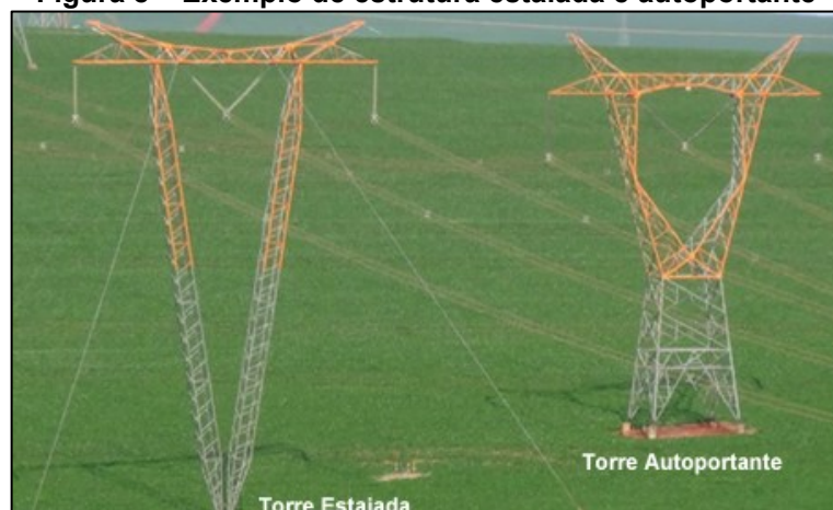
Figura 8 – Exemplo de estrutura estaiada e autoportante
