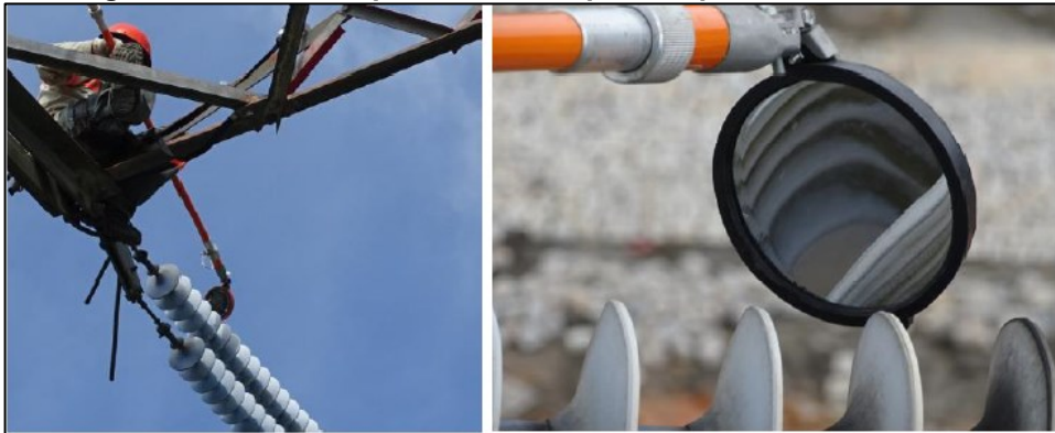
Figura 25 - Uso de espelho côncavo para inspeção de isoladores.
