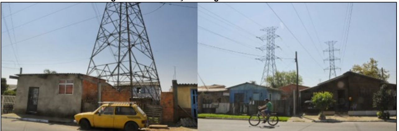
Figura 20 - Construções irregulares sob LT
