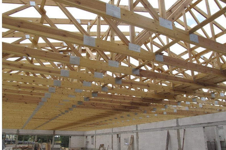
Figura 28: Estrutura de cobertura executada com CDEs
