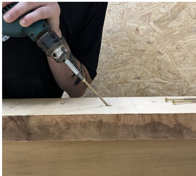
Figura 33 – Instalação de conectores na viga
