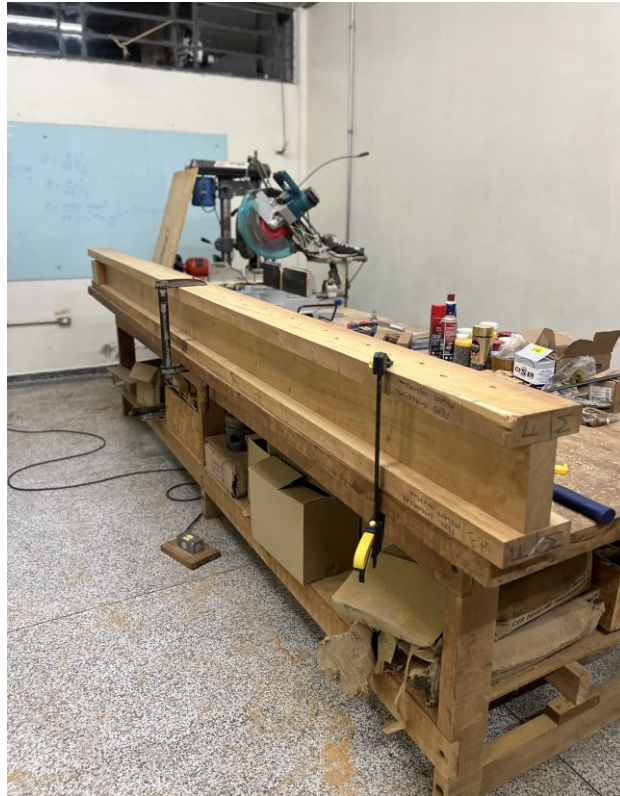
Figura 32 – Montagem da viga composta
