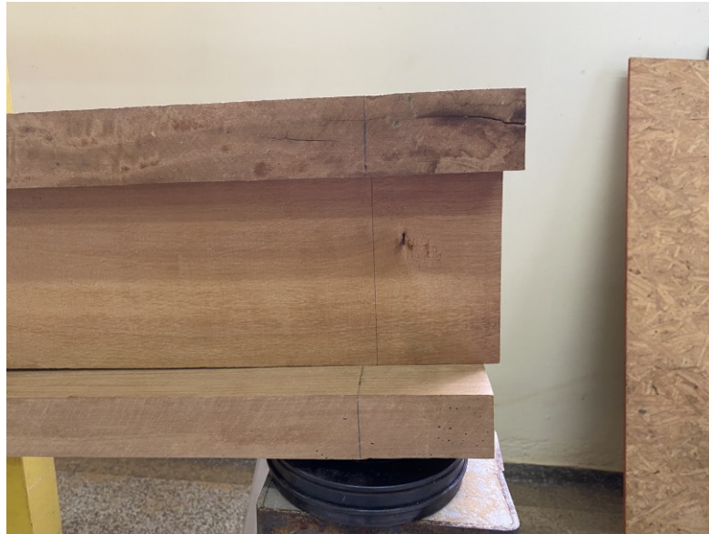
Figura 40 - Deslizamento entre as peças da viga composta
