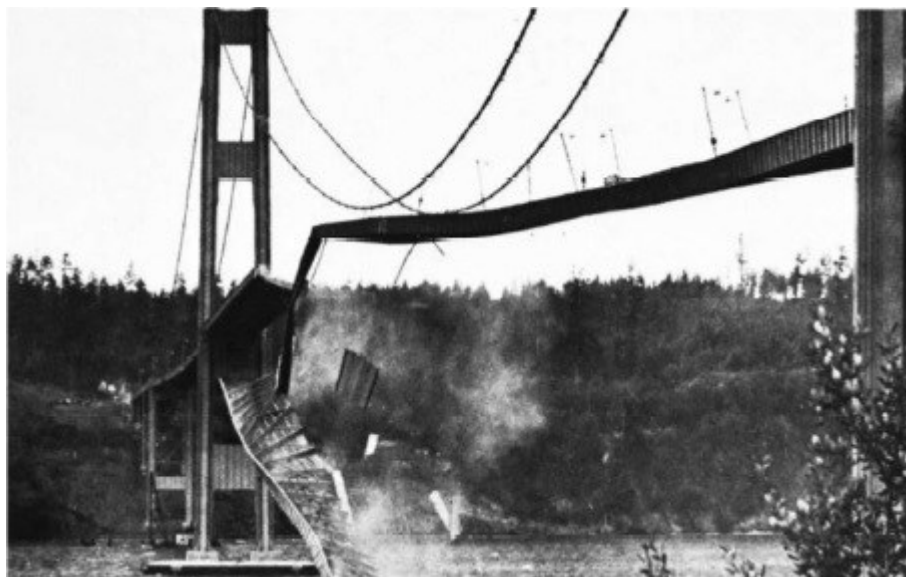
Figura 2 - Ponte de Tacoma durante o seu colapso.
