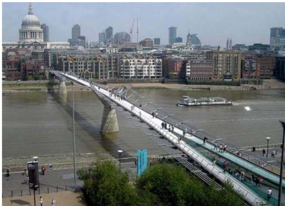
Figura 10 - Passarela Millennium. Londres, Inglaterra.
