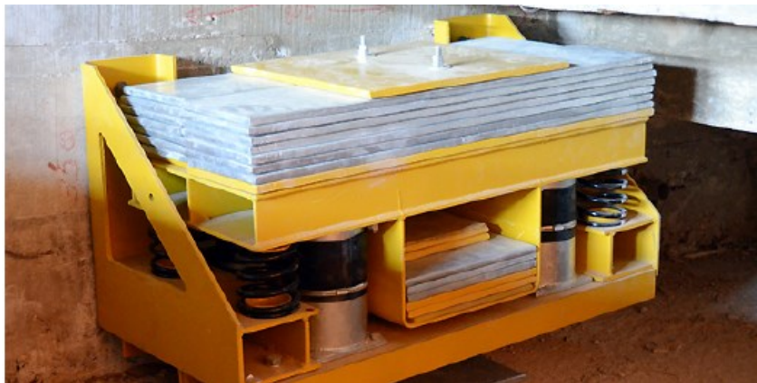
Figura 12 - Aspecto geral dos ADV usados no Estádio do Mineirão.
