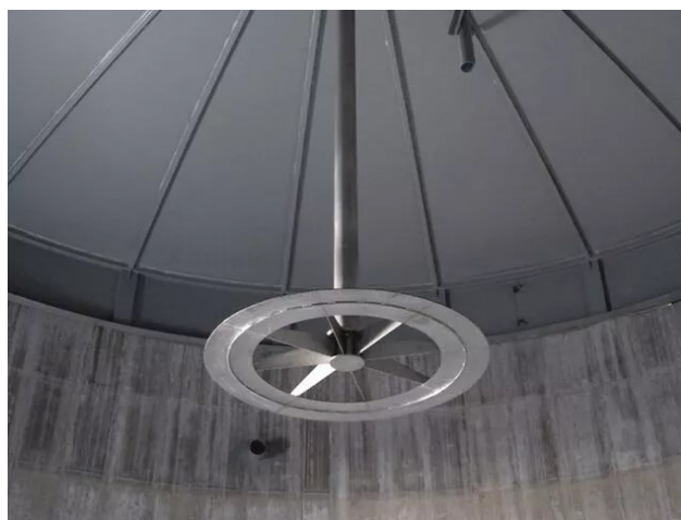
Figura 7 – Exemplo de agitador para biodigestão
