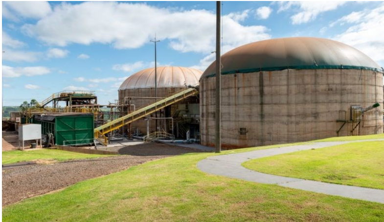
Figura 6 – Biodigestor CSTR Geo Elétrica Tamboara
