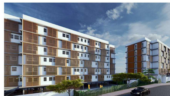
VISTA GERAL CONJUNTO
