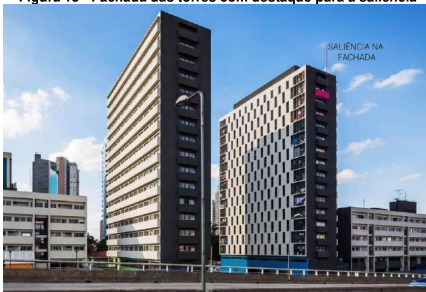
Figura 15 - Fachada das torres com destaque para a saliência
