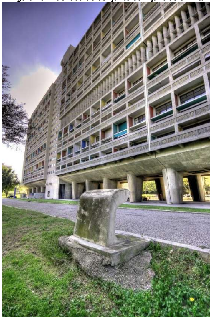
Figura 23 - Fachada do conjunto com janelas em fita
