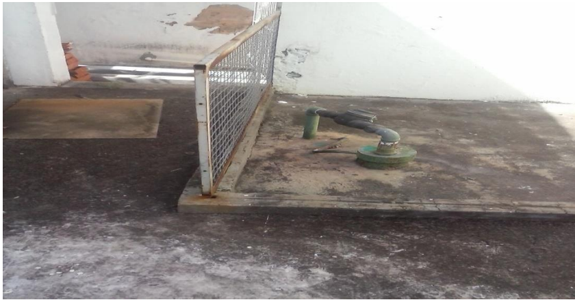
Figura 30 - Condições construtivas e de conservação do poço nº 1
