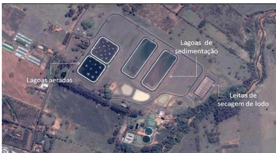
Figura 26 - Estação de tratamento de Esgoto de Tupã-SP
