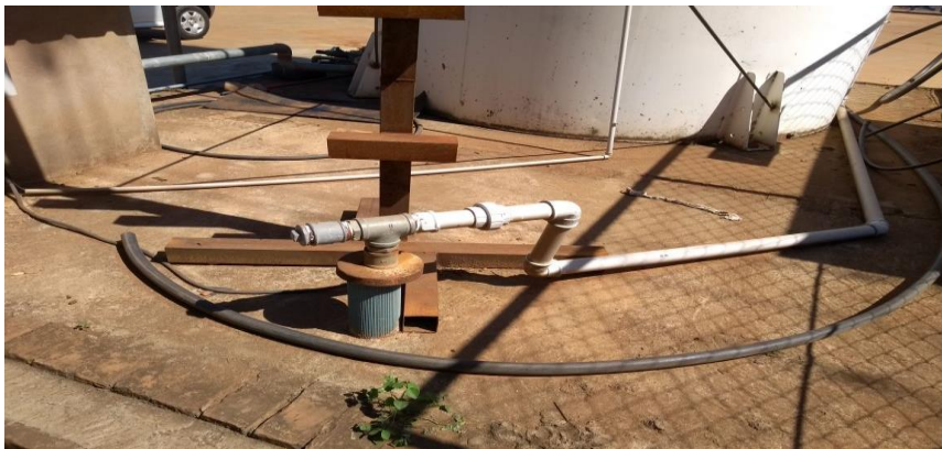
Figura 31 - Condições construtivas e de conservação do poço nº 2
