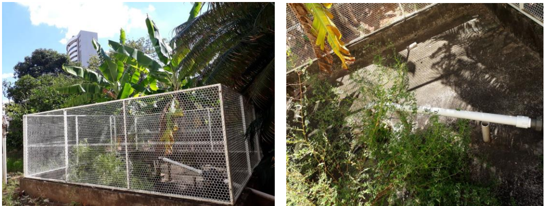
Figura 33 - Condições construtivas e de conservação do poço 20
