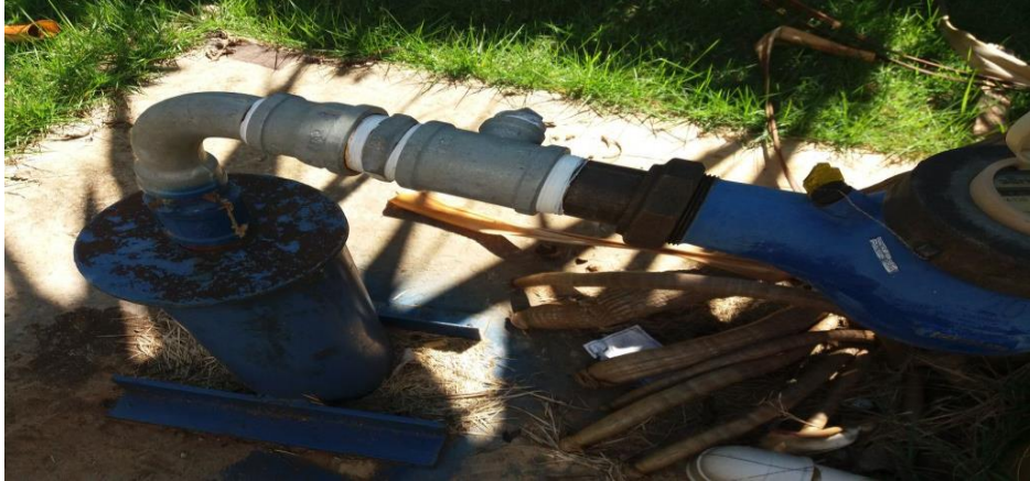
Figura 32 - Condições construtivas e de conservação do poço nº 19
