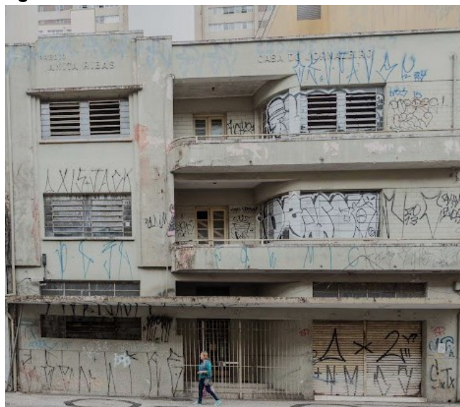
Figura 5 - Edifício Anita Ribas. Fachada da CAPEJO
