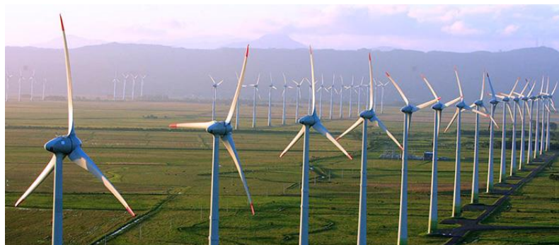
Figura 3 - Parque eólico Onshore
