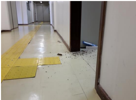
Figura 31: Manutenção Elétrica - Risco de Escorregões
