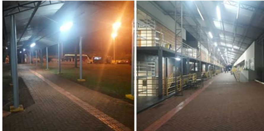
Figuras 11 e 12: Iluminação das rotas acessíveis em ambientes externos cobertos
