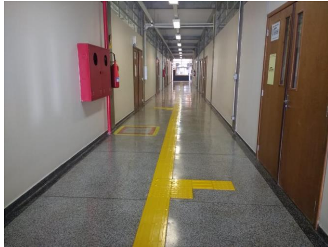
Figura 9: Corredor térreo do bloco E - Piso Granitina
