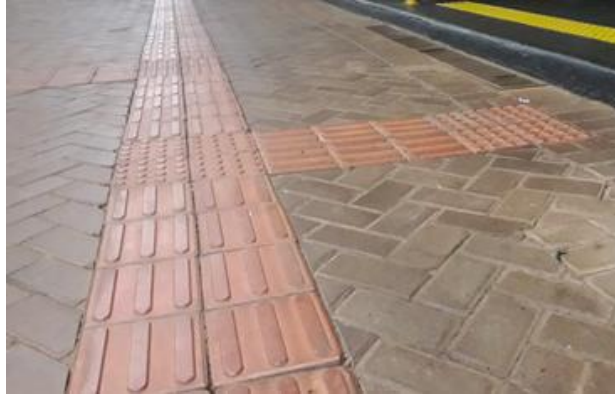
Figura 25: Pisos Táteis de Concreto
