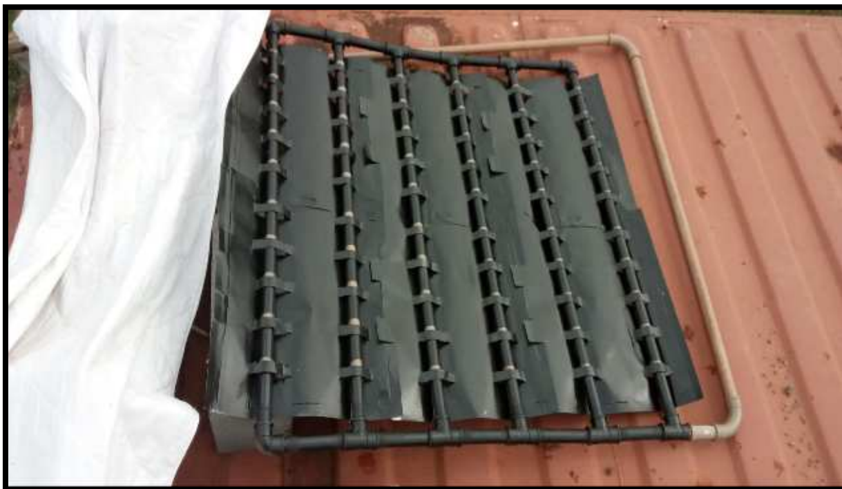
Figura 20 – Imagem fotográfica da unidade experimental completa
