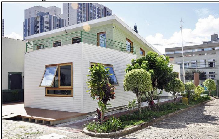
Figura 1 - Vista dos fundos Escritório Verde
