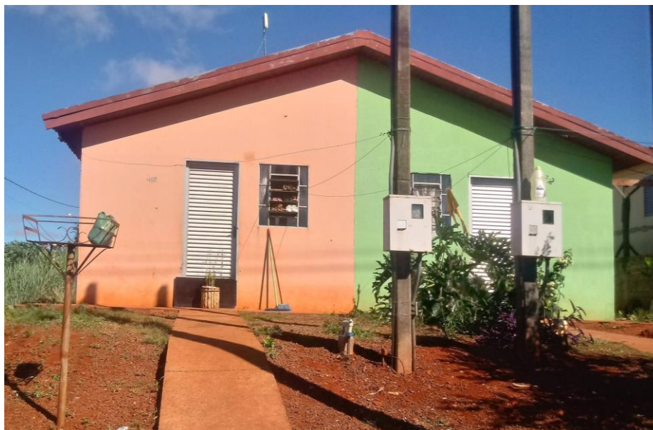
Figura 3.4 – Unidades habitacionais do conjunto Sumatra I
