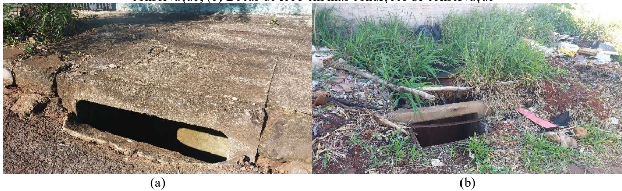
Figura 2.4 - Comparação entre conservação entre bocas de lobo: (a) Bocas de lobo em bom estado de conservação; (b) Bocas de lobo em más condições de conservação
