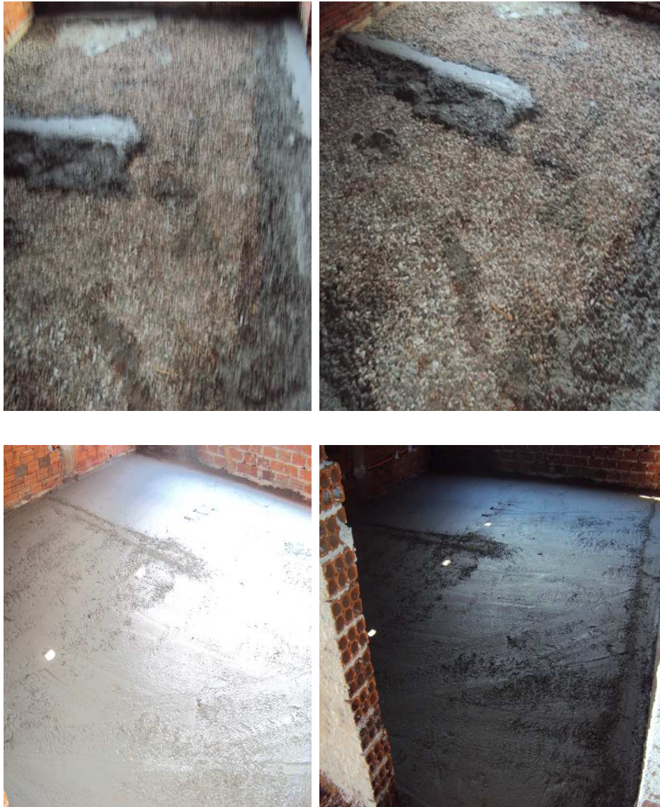
Figura 6 - Execução do contrapiso na ampliação de edificação em alvenaria
