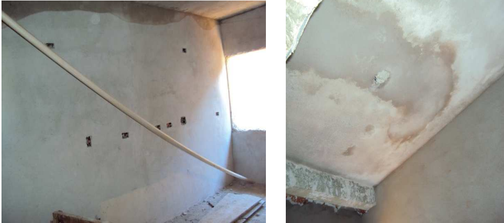
Figura 5 - Execução do emboço nos quartos em uma ampliação de edificação em alvenaria
