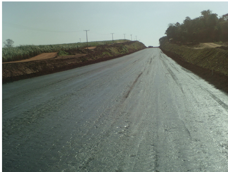
Figura 18 – Emulsão Asfáltica aplicada em pista de rolamento Fonte: O autor
