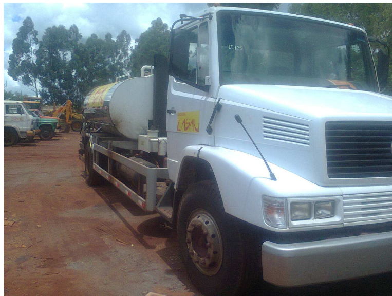
Figura 3 – Espargidor de material asfáltico Fonte: O autor
