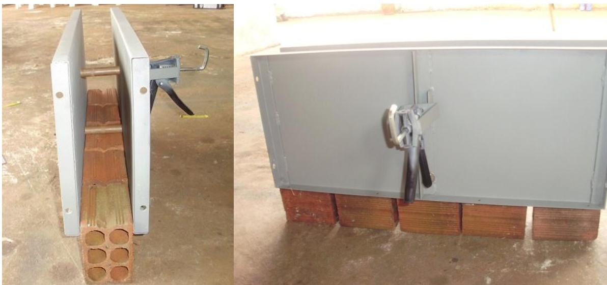
Figura 28 – Pré-montagem da fôrma sobre tijolos Fonte: Autoria própria
