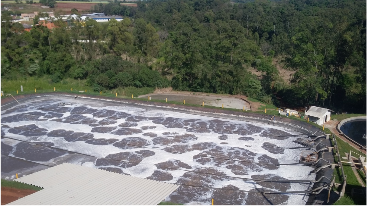
Figura 8 – Lagoa de Estabilização do Curtume Apucarana Leather. Fonte: Autora (2017).
