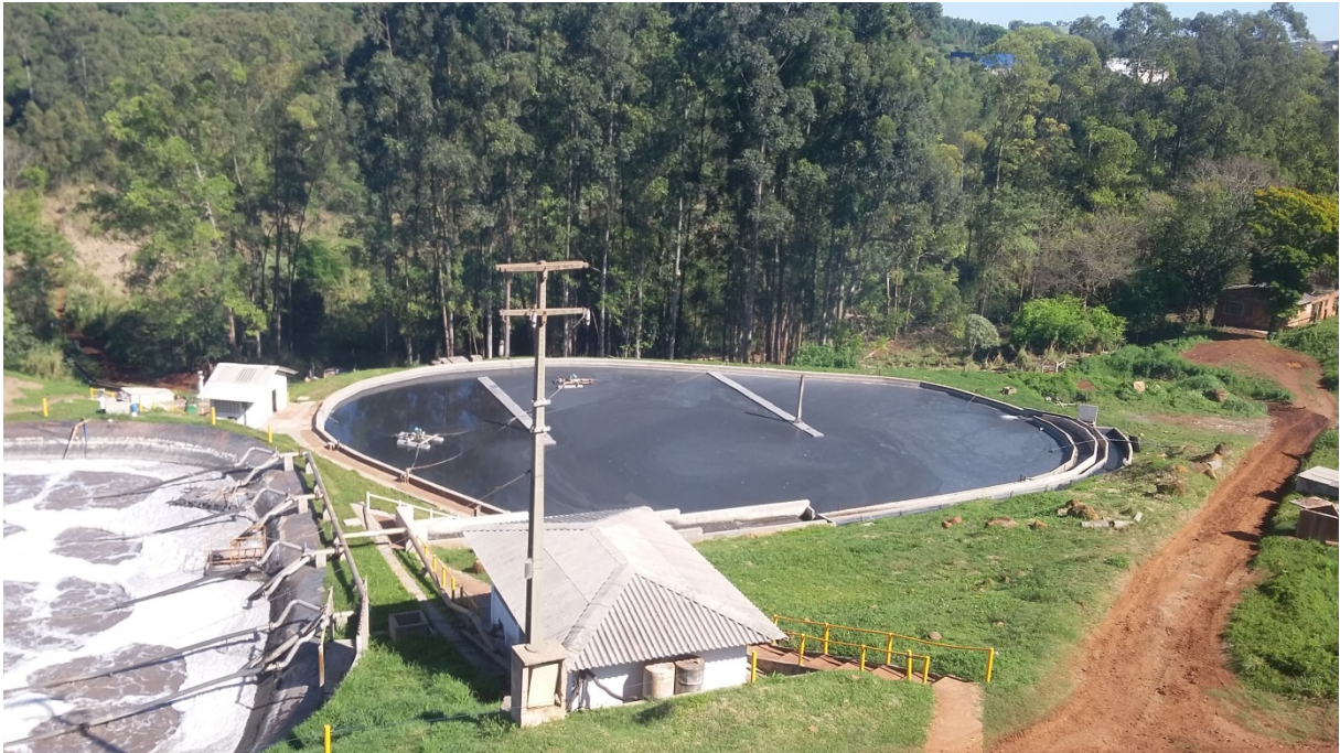
Figura 7 – Lagoa de Desnitrificação do Curtume Apucarana Leather. Fonte: Autora (2017).
