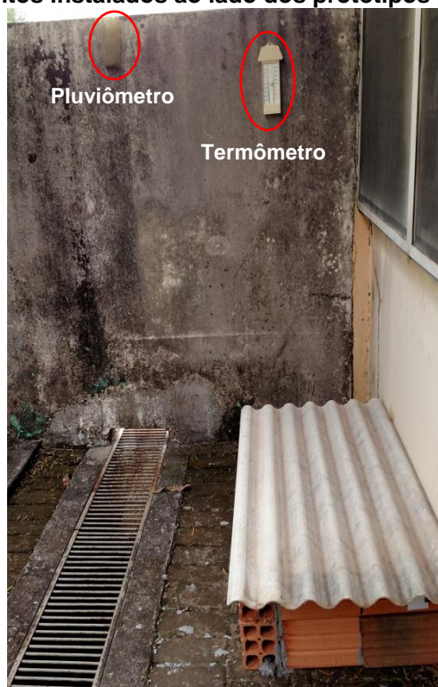
Figura 12 - Equipamentos instalados ao lado dos protótipos para medições externas.
