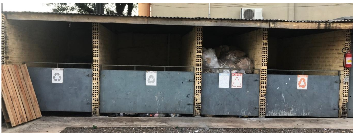
FIGURA 11- Acondicionamento externo de resíduos sólidos
