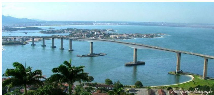
Figura 4: Ponte em concreto protendido - Vitória/ES
