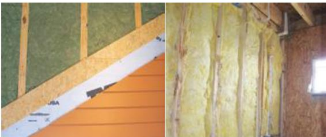
Figura 14 - Isolamento Termoacústico em Painéis Fonte: LP Building Products (2017).
