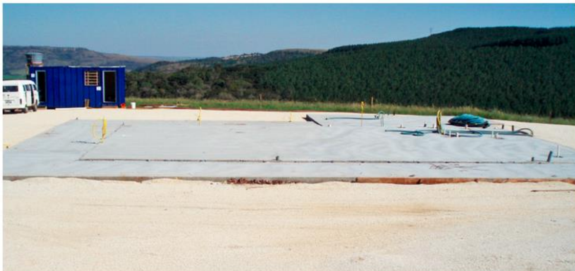
Figura 5 - Fundação tipo Radier Fonte: Smart Sistemas Construtivos (2017).
