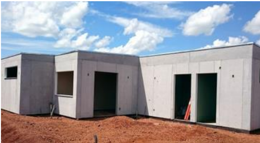
Figura 18 - Fechamento em Placas Cimentícias Fonte: Tecverde (2017).
