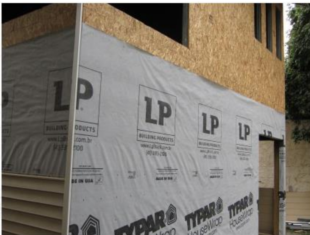
Figura 13 - Membrana Hidrófuga usada para "Envelopar" a construção Fonte: LP Building Products (2017).
