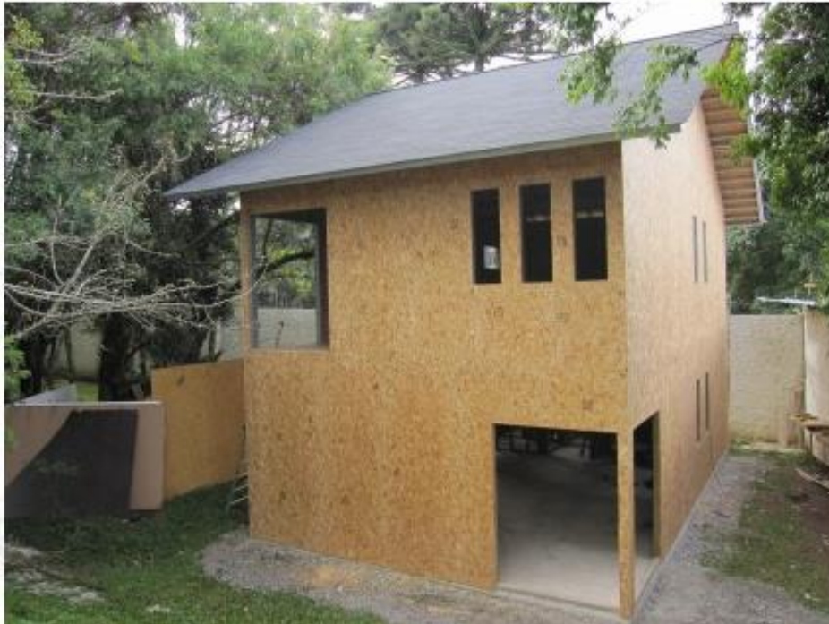
Figura 17 - Fechamento em OSB Fonte: LP Building Products (2017).
