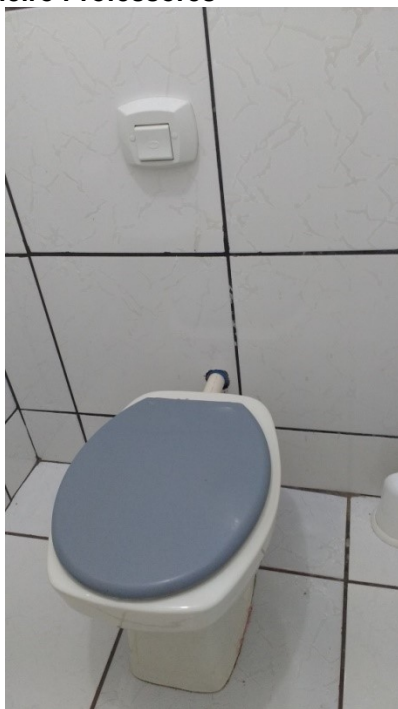
Figura 14 – Vaso Sanitário Banheiro Professores
