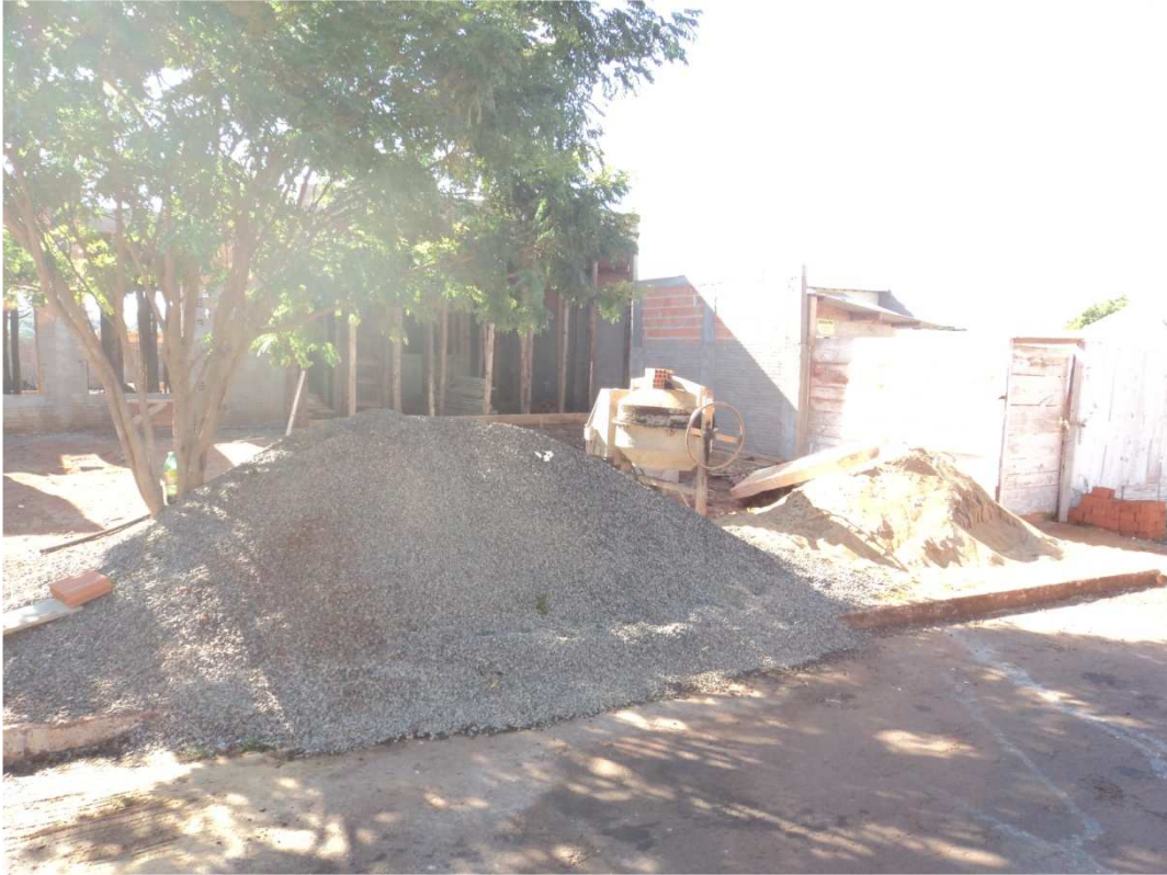
Figura 21 - Canteiro de obras da obra 04.
