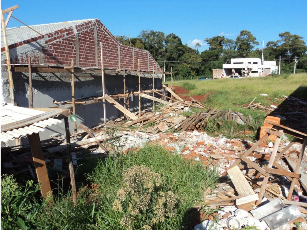
Figura 26 - Canteiro de obras da obra 05.
