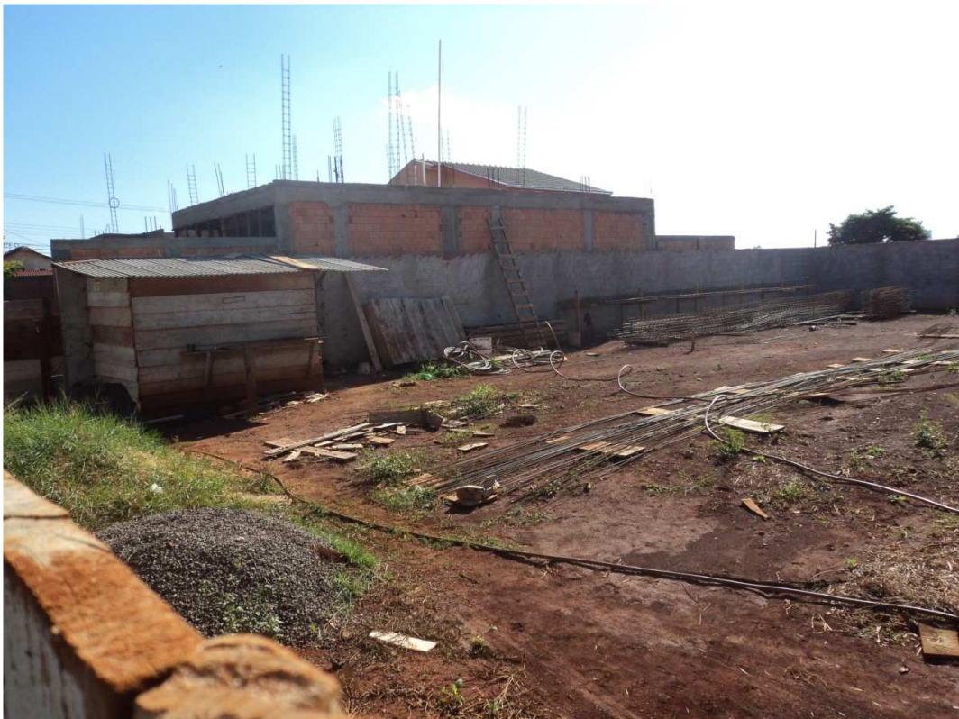
Figura 22 - Canteiro de obras da obra 04.
