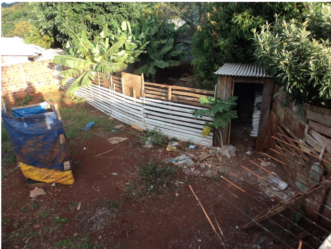
Figura 37 - Canteiro de obras da obra 07.
