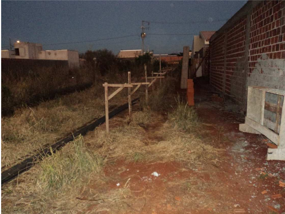
Figura 7 - Canteiro de obras da obra 01.
