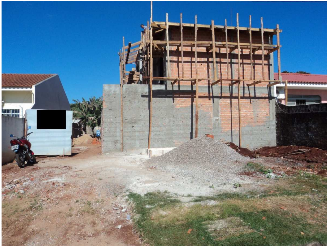
Figura 50 - Vista frontal do canteiro de obras da obra 10.
