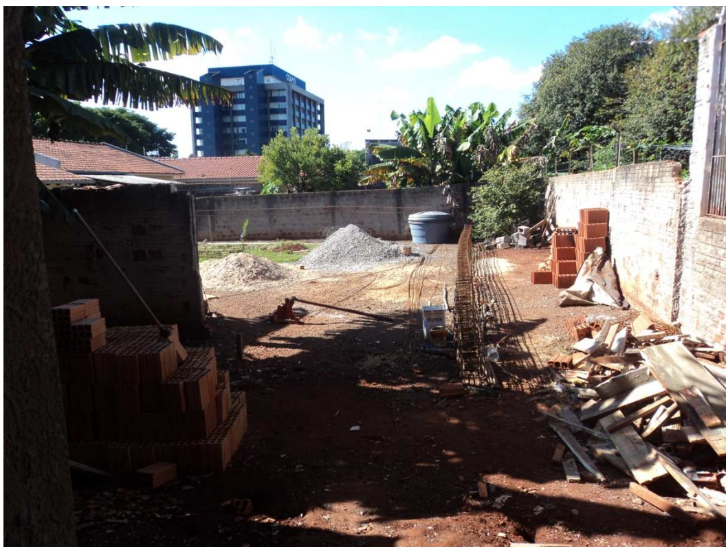
Figura 52 - Canteiro de obras da obra 10.
