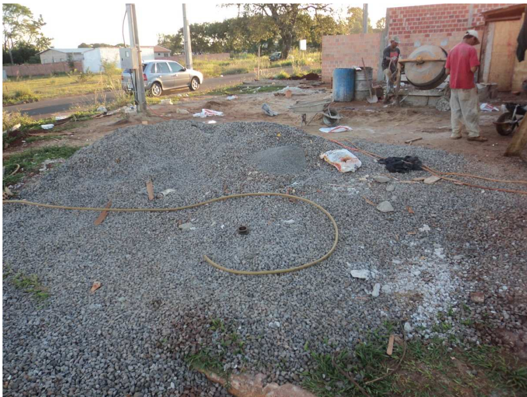
Figura 42 - Canteiro de obras da obra 08.
