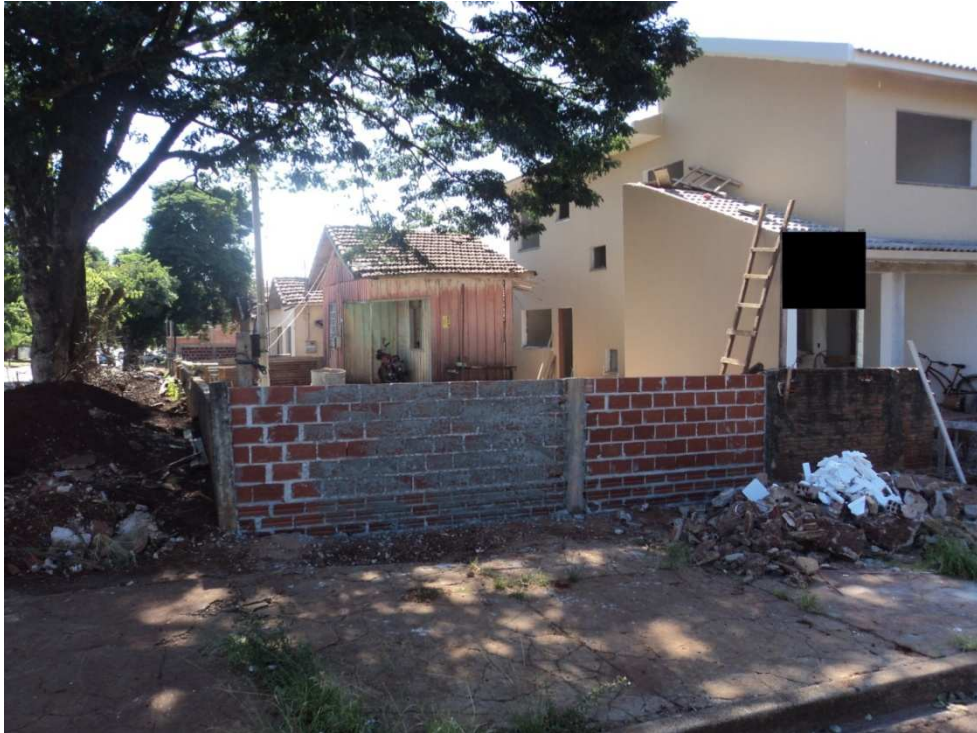
Figura 10 - Vista frontal do canteiro de obras da obra 02.
