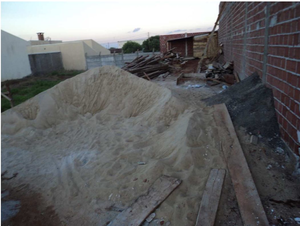
Figura 47 - Canteiro de obras da obra 09.
