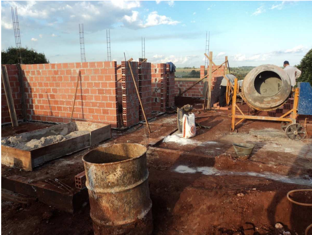
Figura 36 - Canteiro de obras da obra 07.
