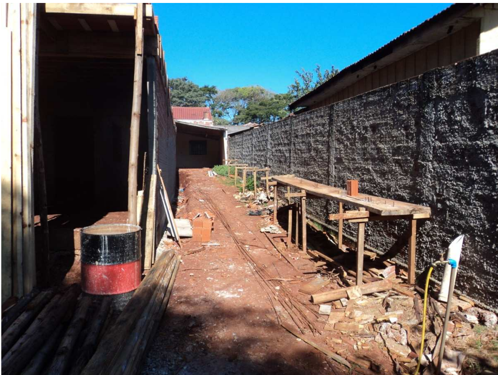
Figura 17 - Canteiro de obras da obra 03.
