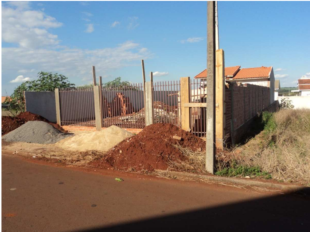
Figura 30 - Vista frontal do canteiro de obras da obra 06.
