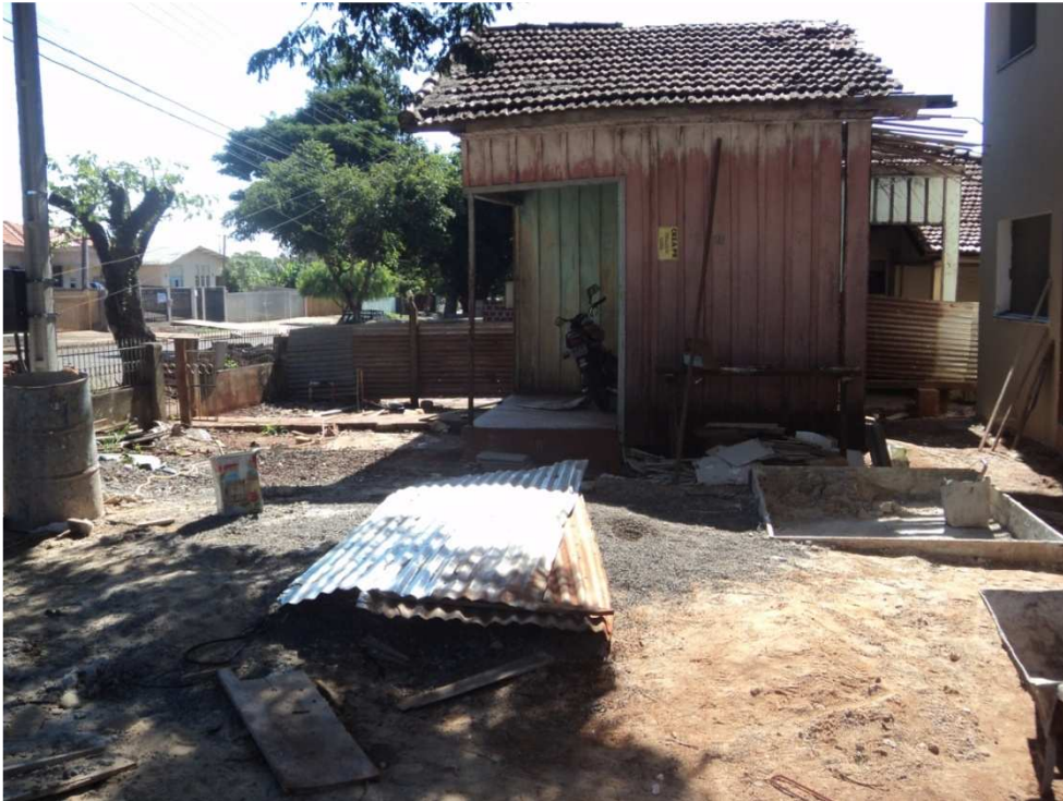
Figura 11 - Canteiro de obras da obra 02.
