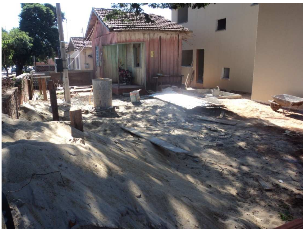
Figura 12 - Canteiro de obras da obra 02.
