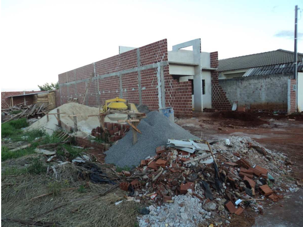
Figura 46 - Canteiro de obras da obra 09.
