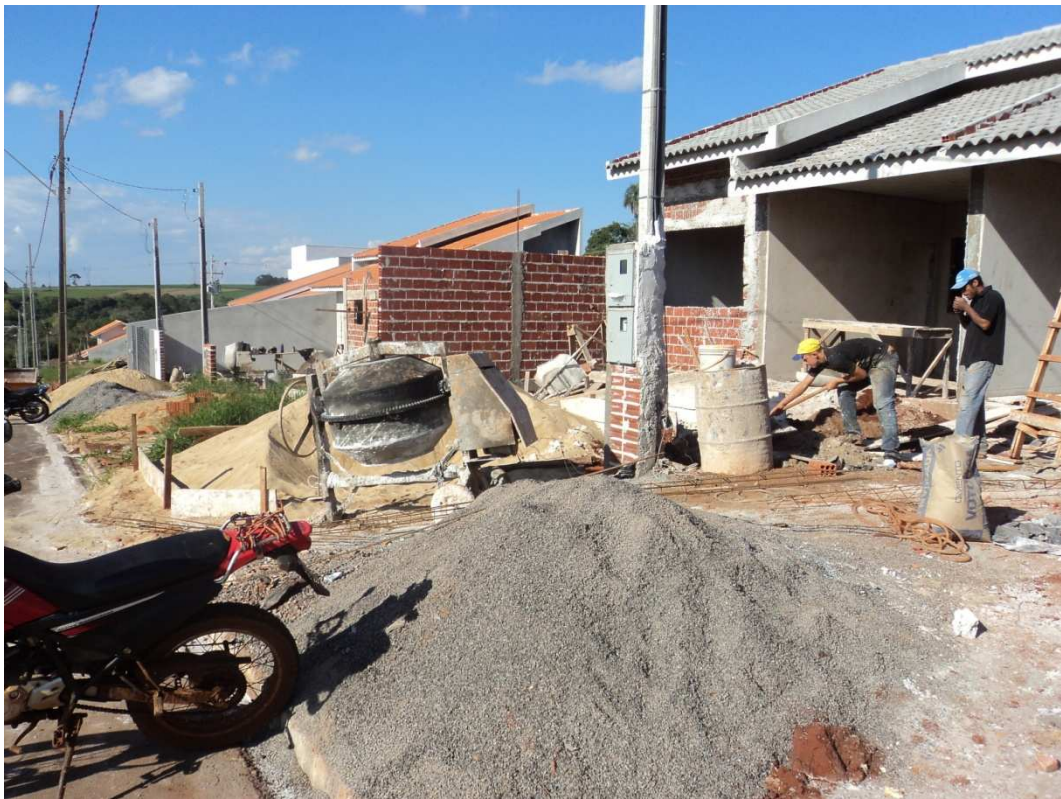
Figura 25 - Vista frontal do canteiro de obras da obra 05.
