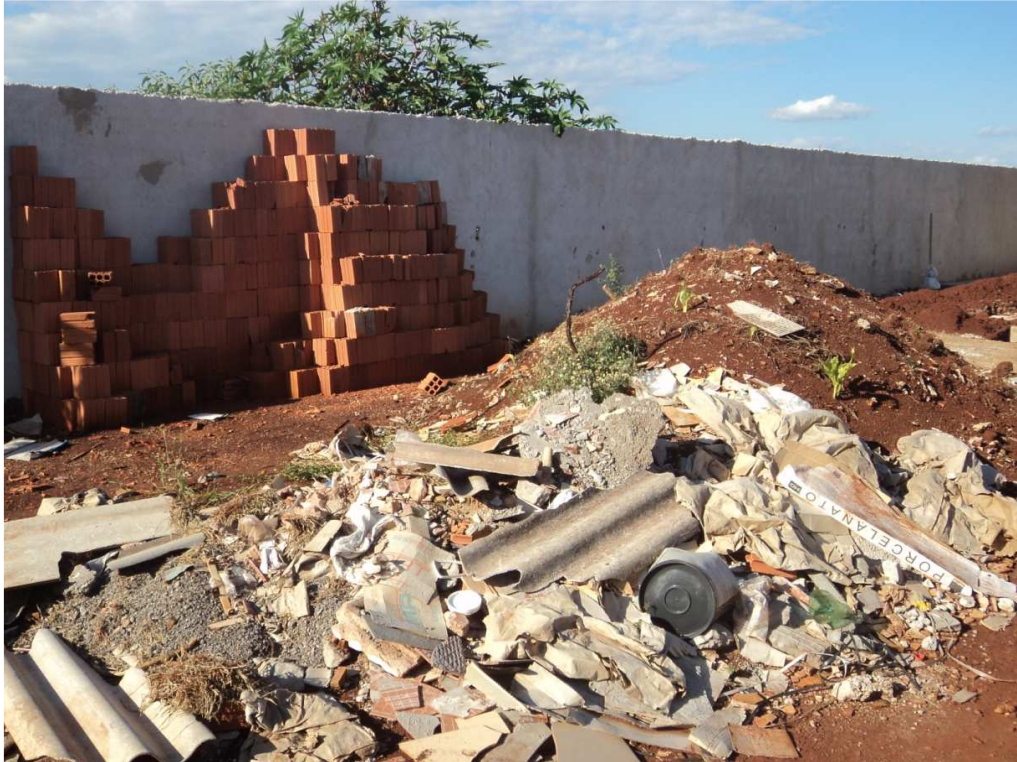
Figura 31 - Canteiro de obras da obra 06.
