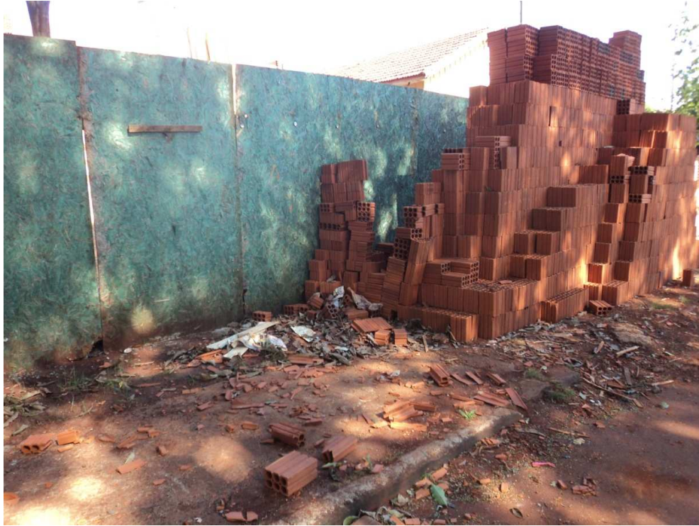
Figura 15 - Vista frontal do canteiro de obras da obra 03.
