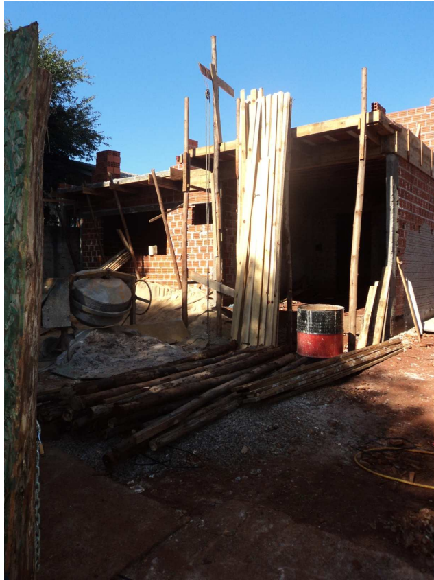
Figura 16 - Canteiro de obras da obra 03.
