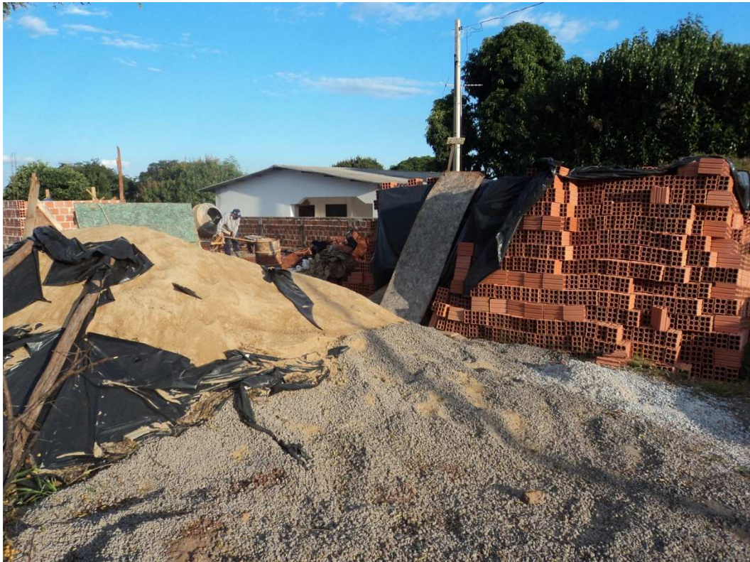
Figura 35 - Vista frontal do canteiro de obras da obra 07.
