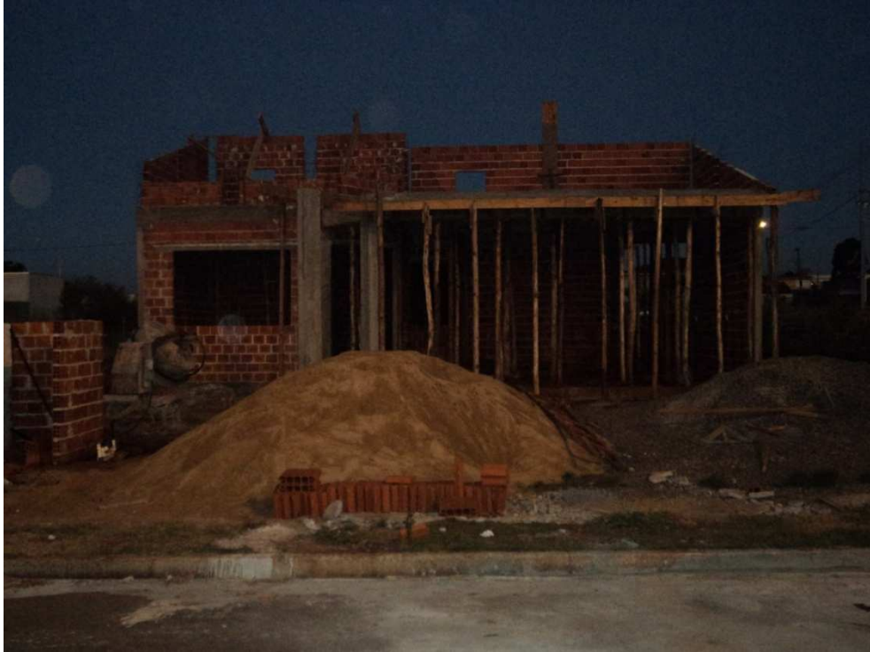
Figura 5 - Vista frontal do canteiro de obras da obra 01.
