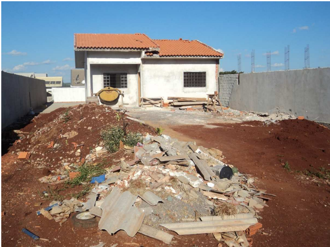
Figura 32 - Canteiro de obras da obra 06.
