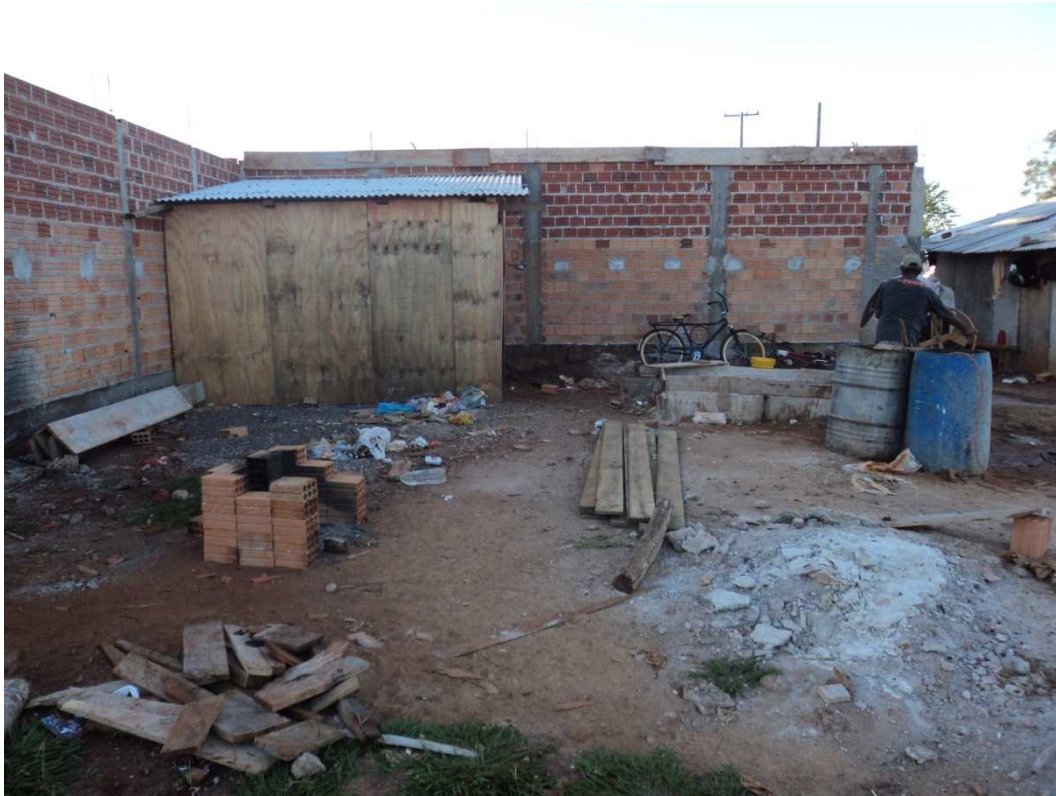
Figura 41 - Canteiro de obras da obra 08.
