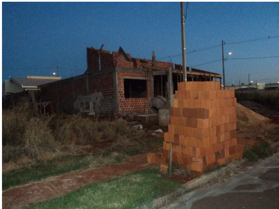
Figura 6 - Canteiro de obras da obra 01.
