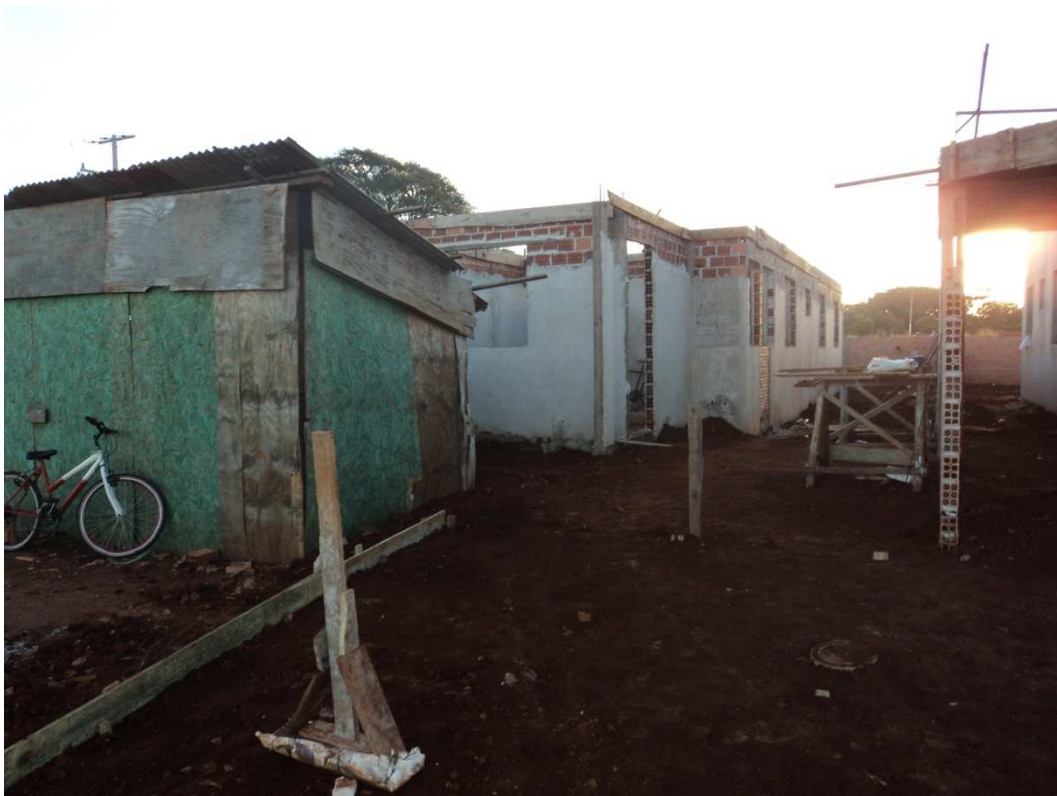
Figura 40 - Vista frontal do canteiro de obras da obra 08:
