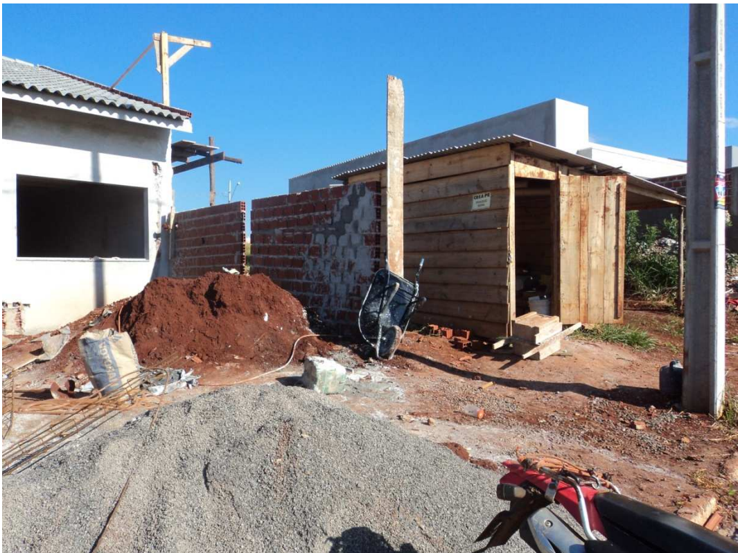
Figura 27 - Canteiro de obras da obra 05.
