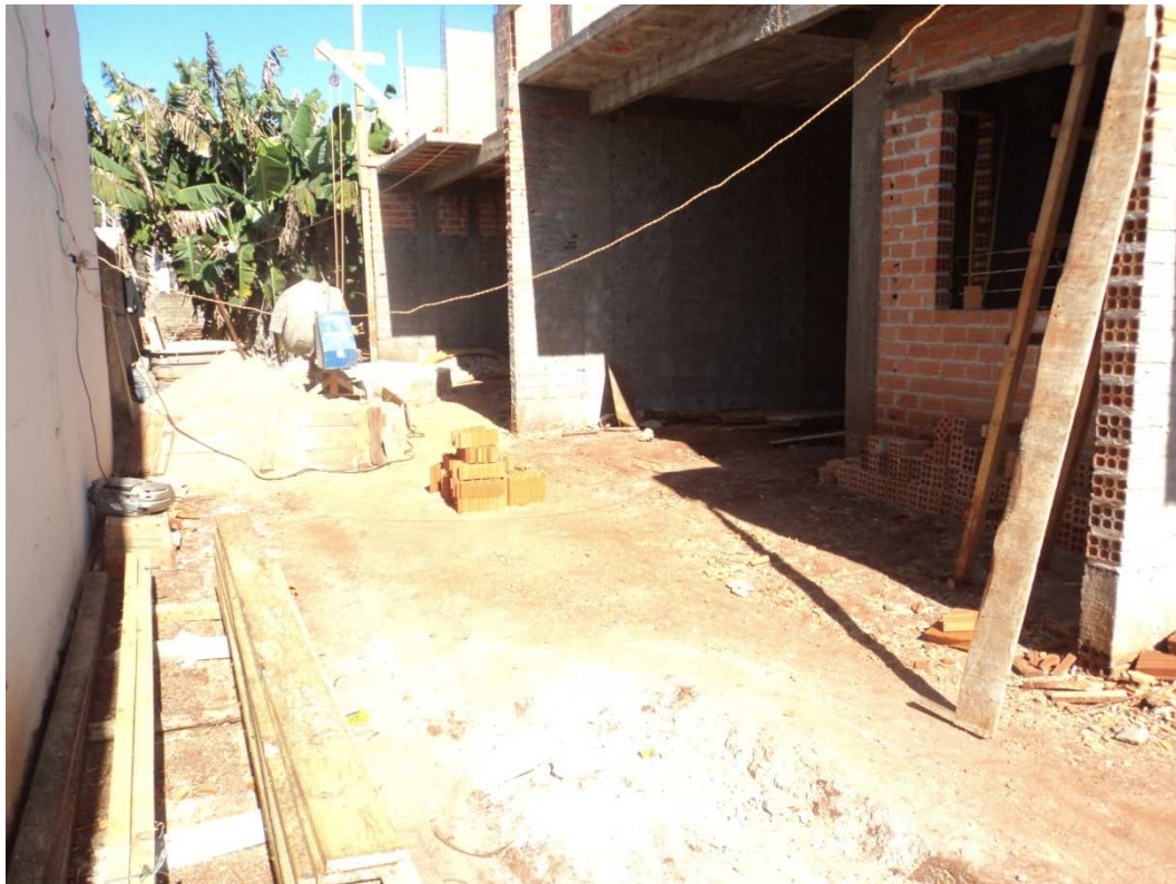
Figura 51 - Canteiro de obras da obra 10.
