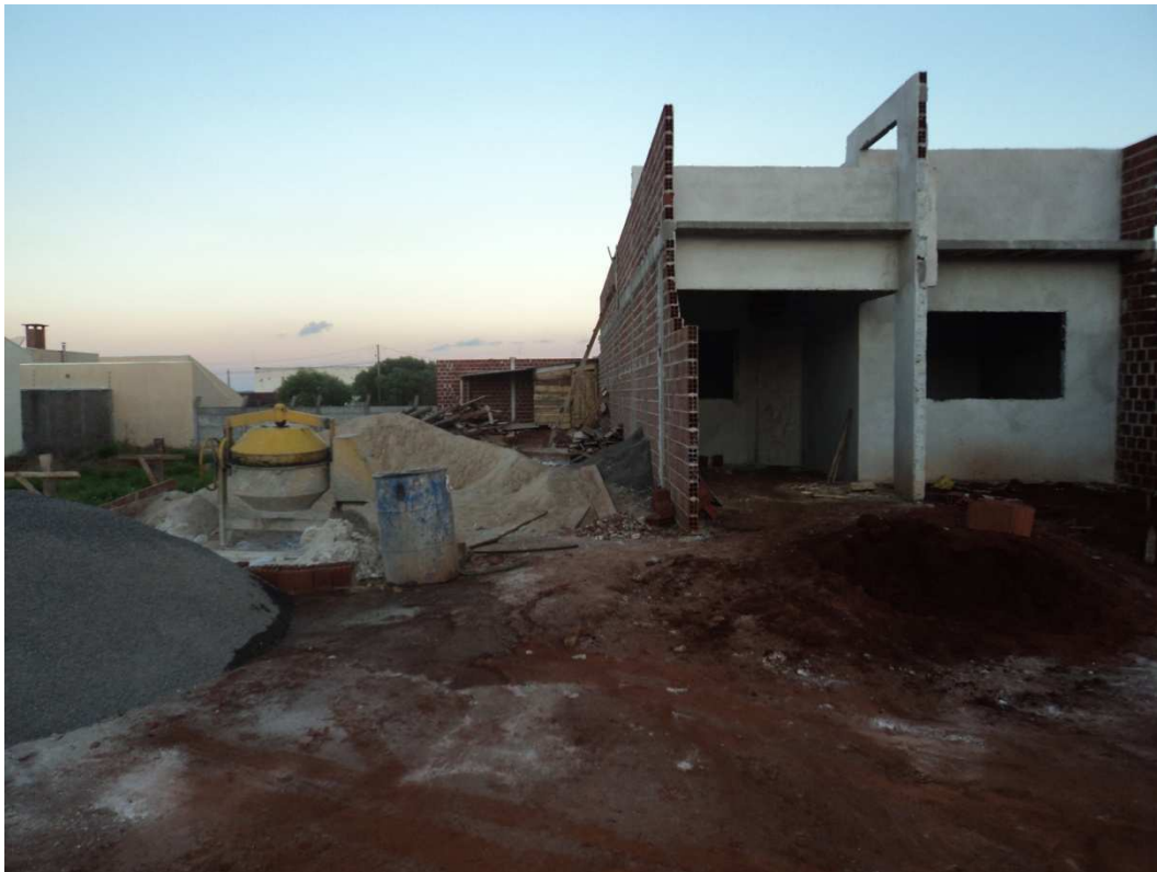
Figura 45 - Vista frontal do canteiro de obras da obra 09.
