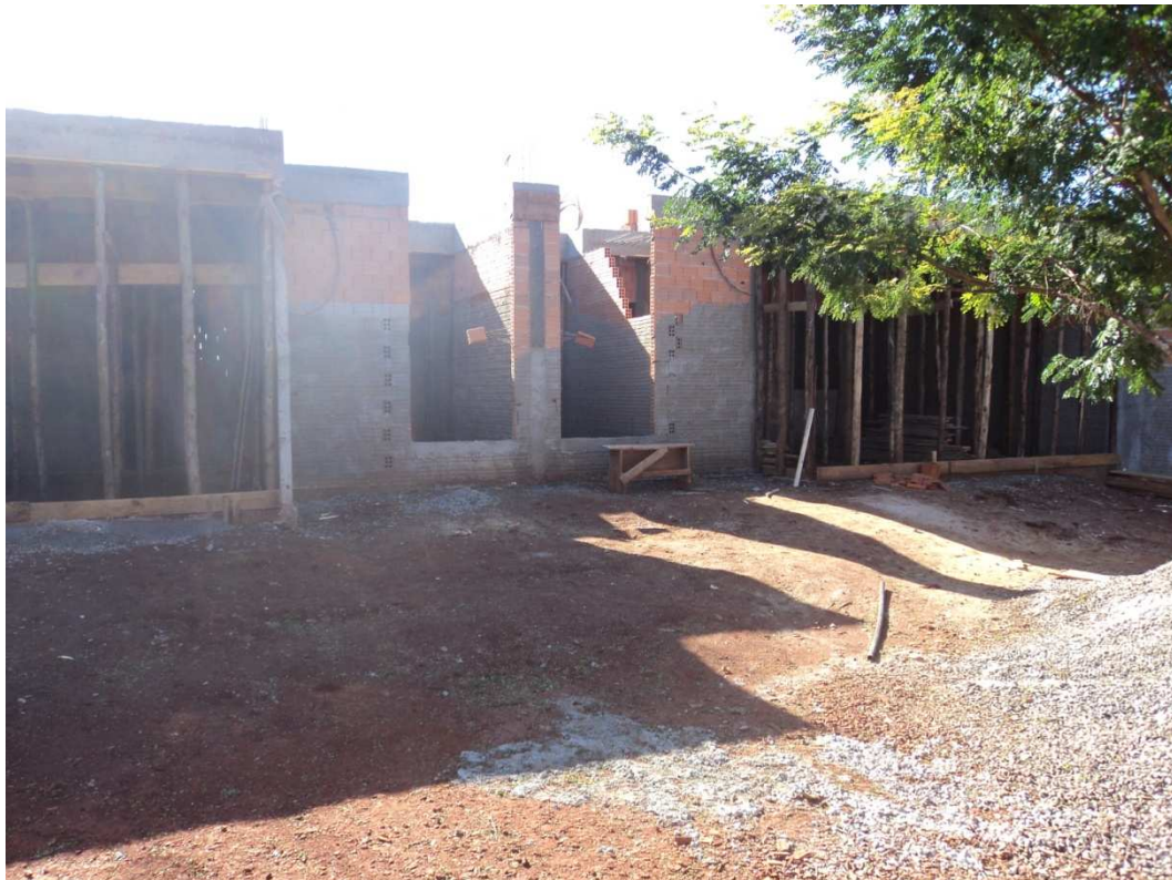
Figura 20 - Vista frontal do canteiro de obras da obra 04.
