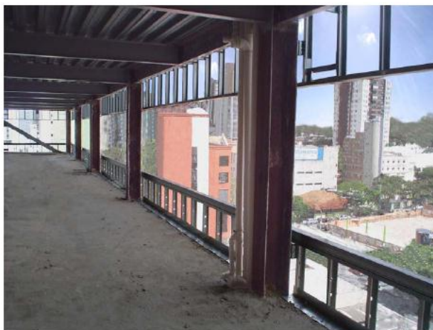
Figura 11 – Obra com fechamento externo em LSF em Belo Horizonte Fonte: Santiago (2008)
