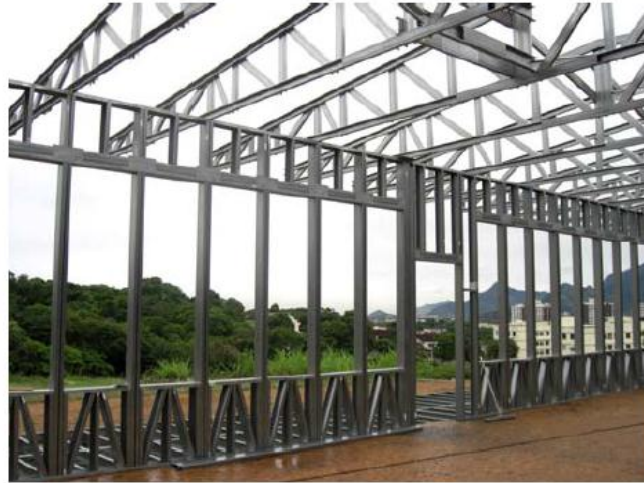
Figura 10 – Obra de escola em LSF no Rio de Janeiro Fonte: Santiago (2008)
