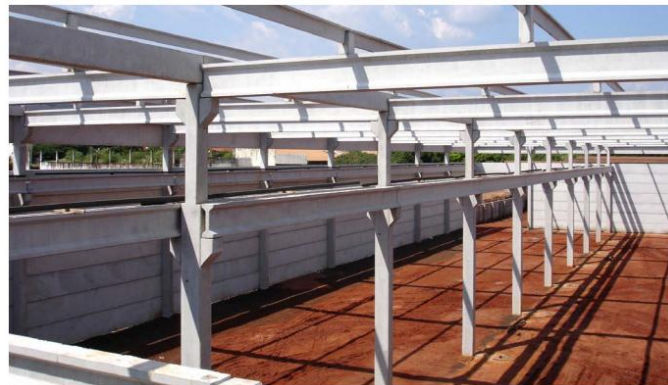
Figura 6 – Obra realizada pela Empresa SUDESTE Fonte: SUDESTE (2012)
