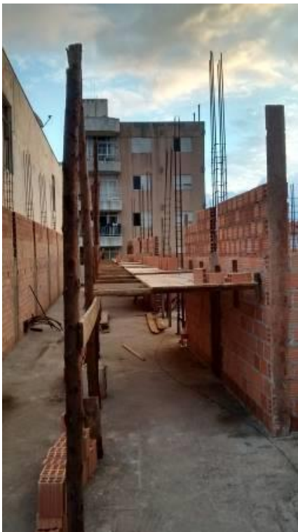
FIGURA 9 – ANDAIMES DE MADEIRA
