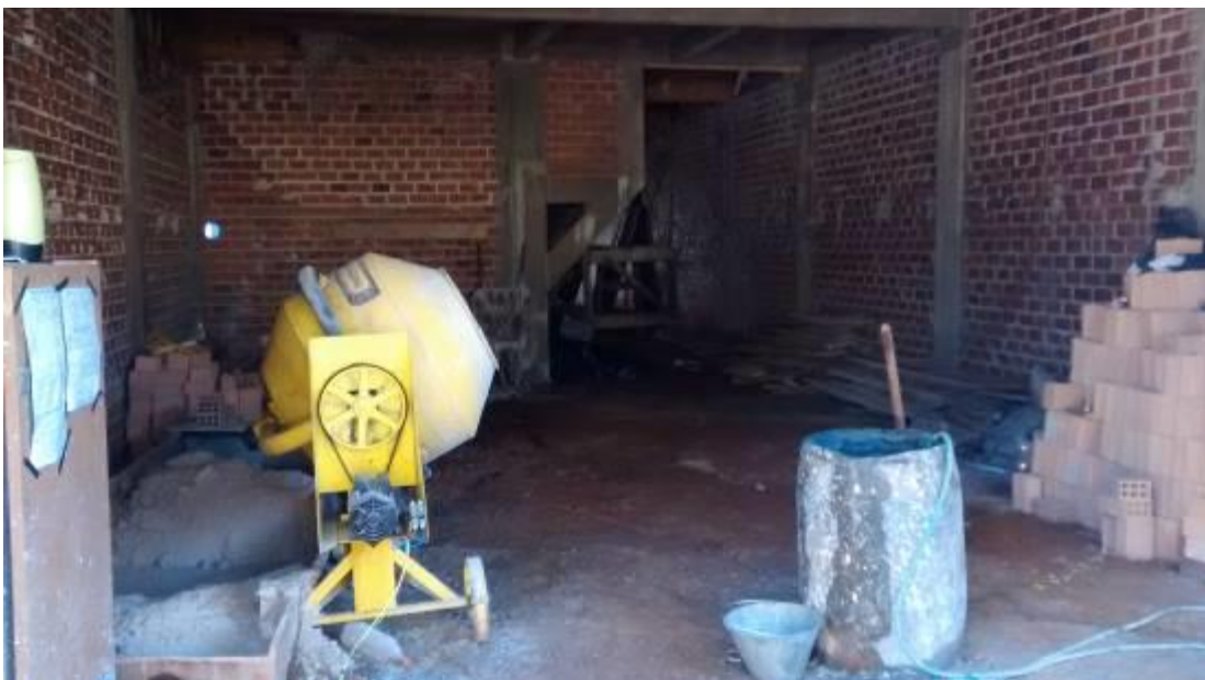
FIGURA 7 – BETONEIRA 400 LITROS, área de produção da argamassa
