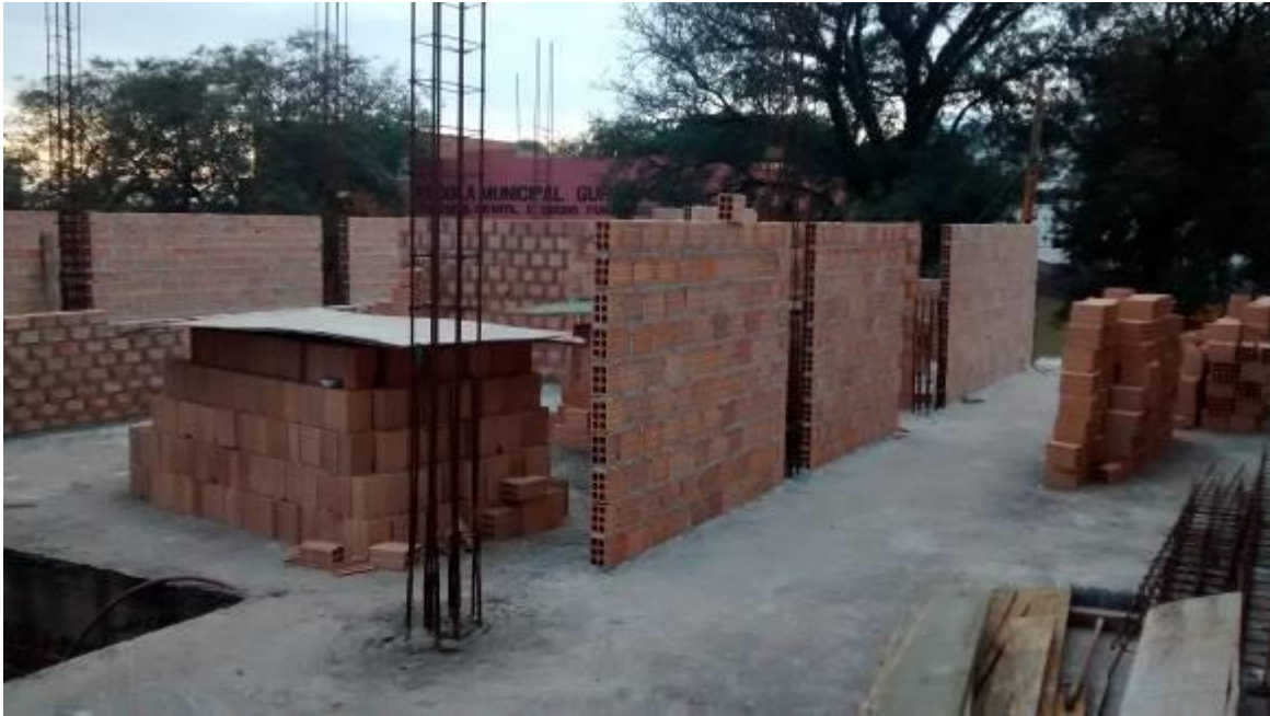
FIGURA 13 – ALVENARIAS \frac{1}{2} VEZ E 1 VEZ
