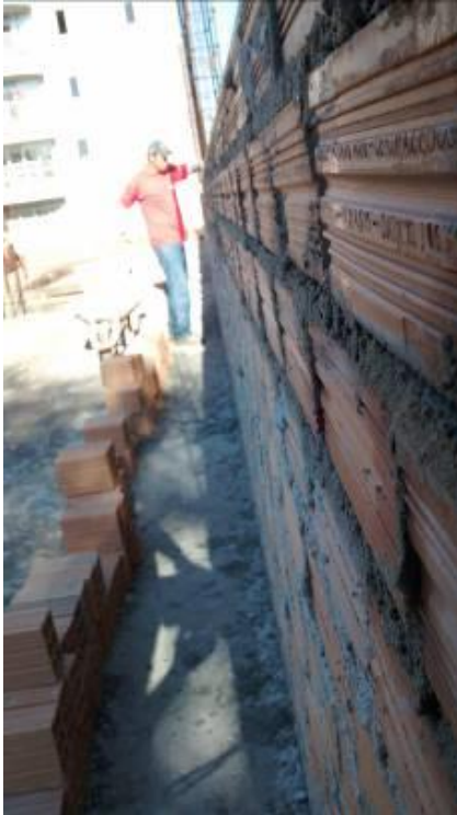
FIGURA 8 – DETALHE DAS JUNTAS ENTRE BLOCOS
