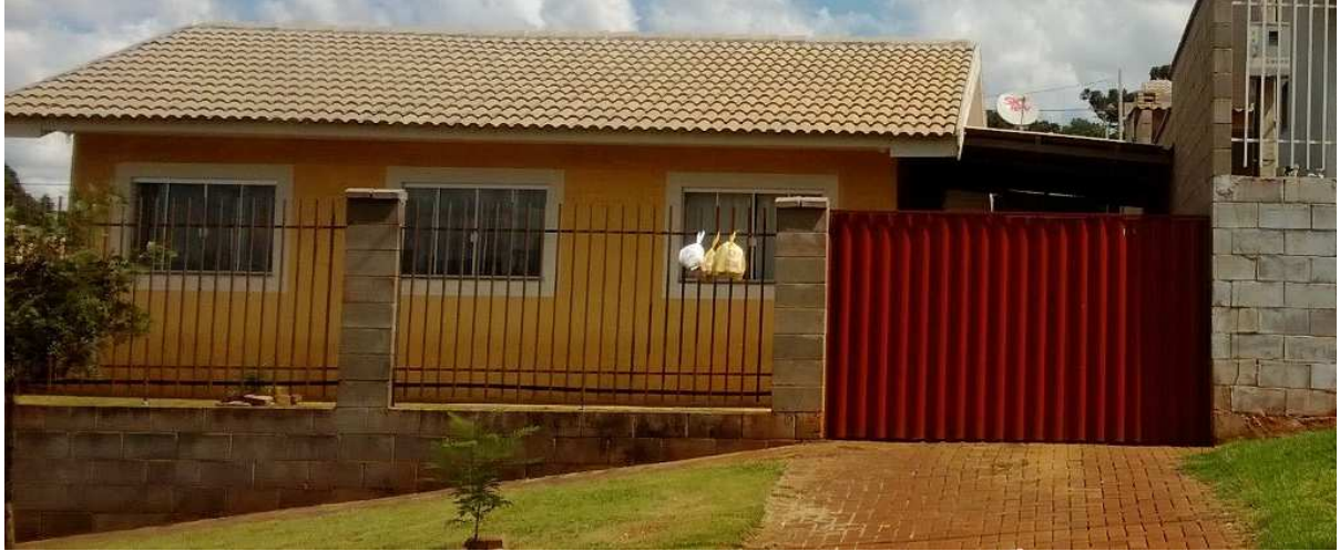
Fotografia 4 – Telhado da garagem com inclinação inferior a recomendada Fonte: Autoria própria
