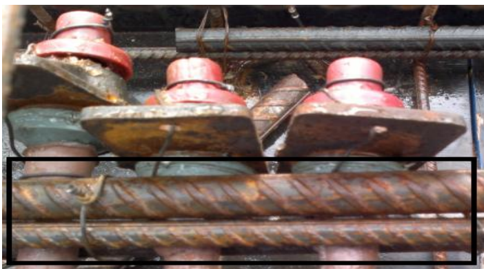
Figura 24 – Barra de aço com função de fretagem
