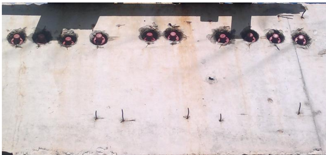
Figura 27 – Dispositivo plástico fixado nas extremidades dos cabos
