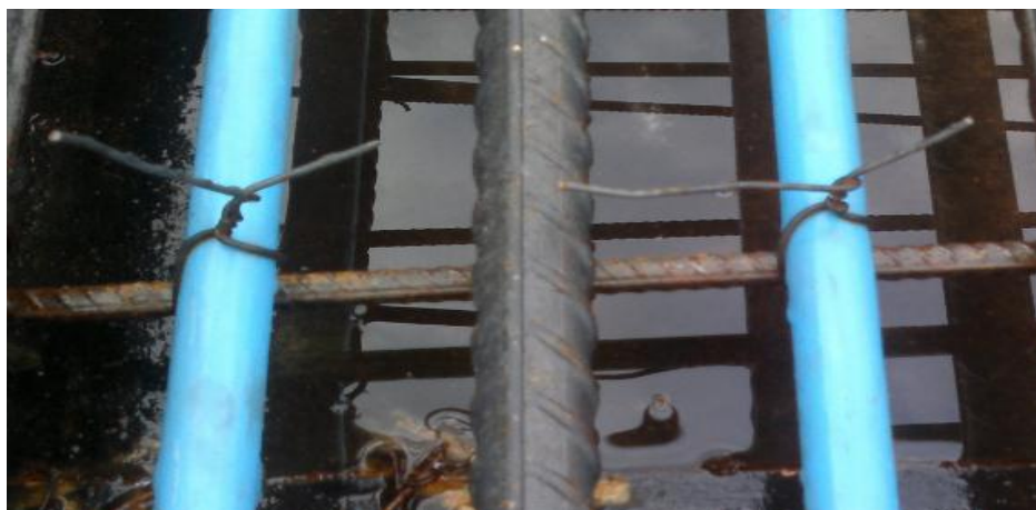
Figura 23 – Ponto com arame, fixação dos cabos
