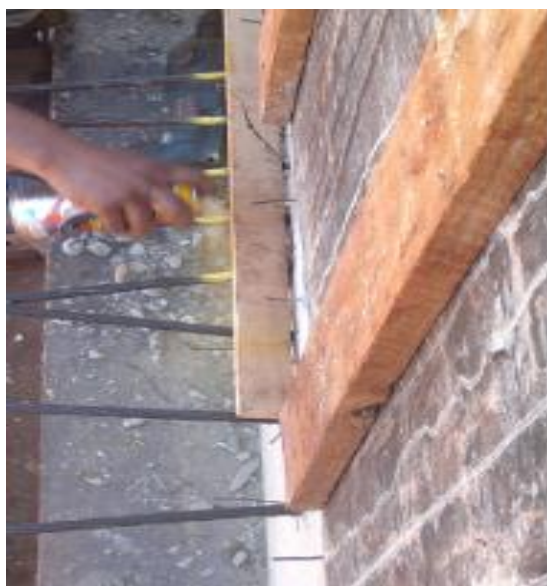
Figura 26 – Marcação com spray para anotação do alongamento
