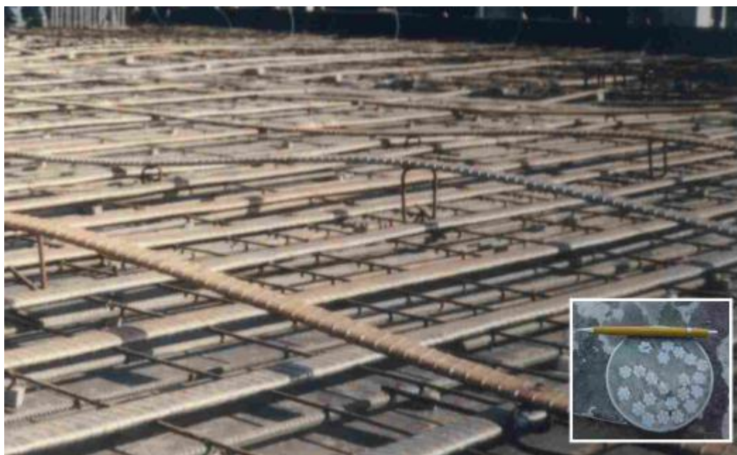
Figura 5 – Protensão com aderência posterior e corpo de prova Fonte: Catálogo Rudloff (2012).
