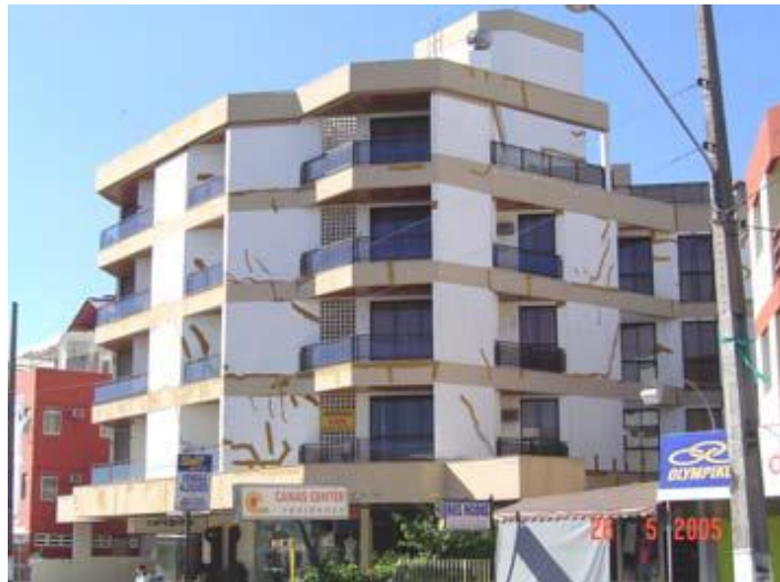
Figura 16 - Fissuração generalizada
