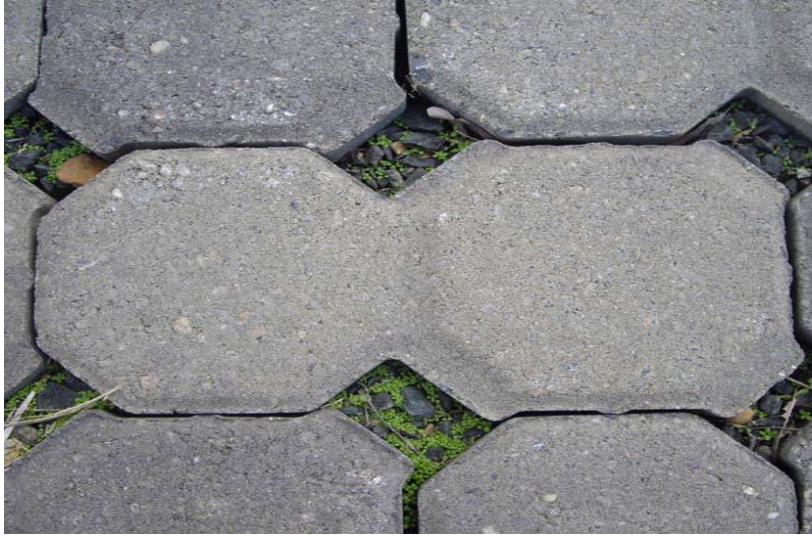
Figura 2 - Pavimento permeável com peças pré-moldadas Fonte: ABCP (Associação Brasileira de Cimento Portland, 2010)
