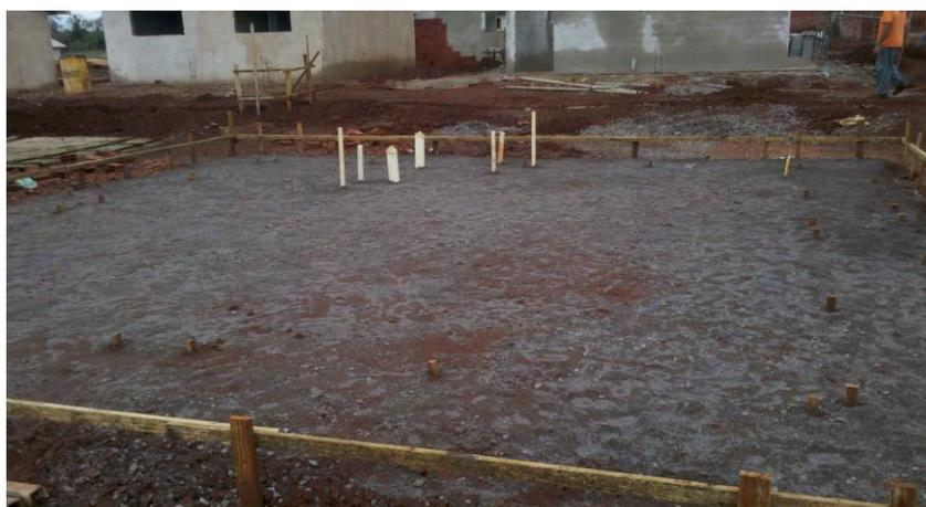
**Fotografia 14 – Marcação para Encaixe das Formas Metálicas**
