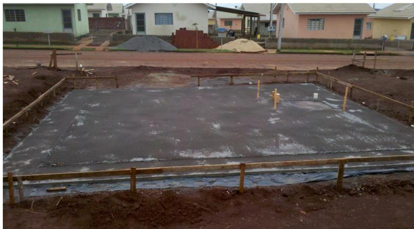
**Fotografia 21 – Radier Finalizado com Camada de Pedrisco e Água**
