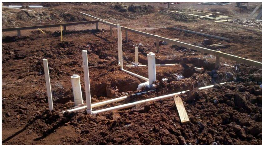
**Fotografia 13 – Tubulação de Esgoto**
