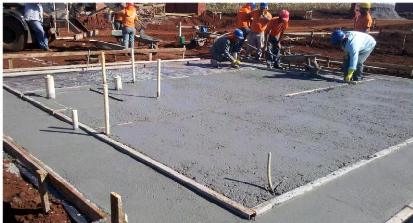
**Fotografia 19 – Execução do Radier e Desempeno da Parte Externa**
