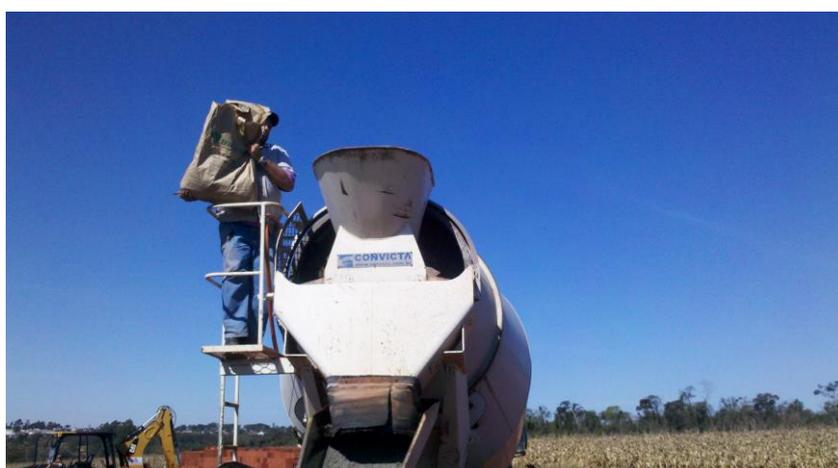
**Fotografia 16 – Adição e Mistura das Fibras de Aço Corrugado ao Concreto**
