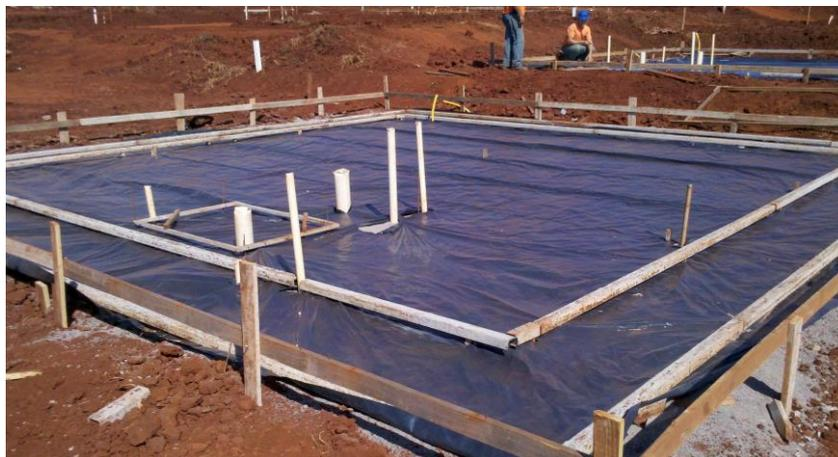
**Fotografia 15 – Aplicação da Lona e Formas Metálicas**
