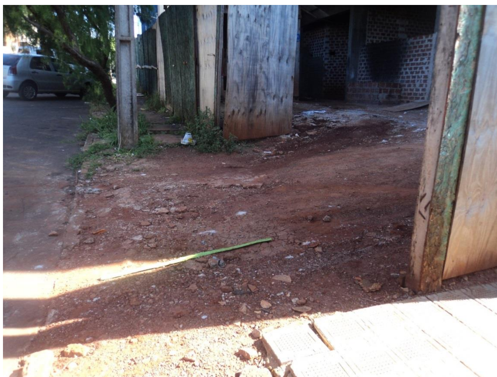
Figura 6: Entrada de veículos do Edifício Philadelphia Fonte: Foto retirada pela autora em março/2014
