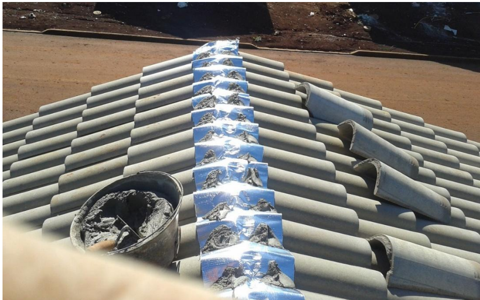
Figura 8 - Serviço de colocação da manta de alumínio sendo executado
