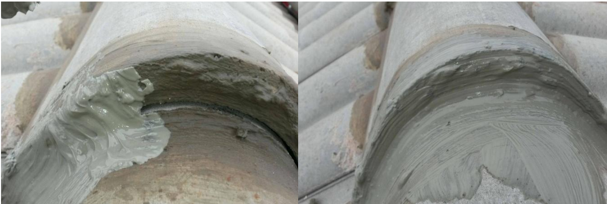
Figura 9 - Aplicação da manta líquida
