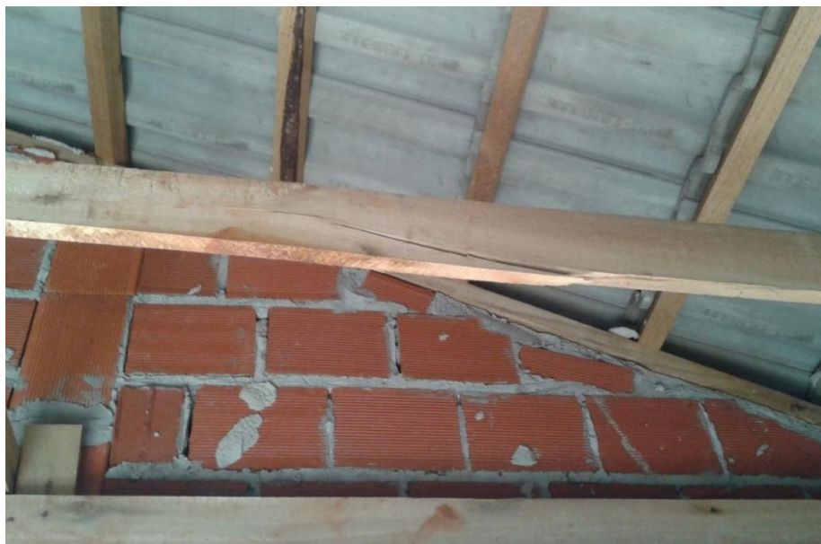
Figura 12 - Peça da estrutura de madeira partida
