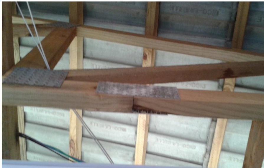
Figura 11 - Chapa com dentes expostos
