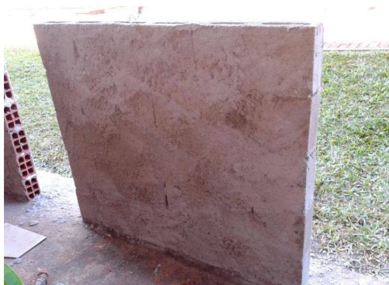
Figura 13 - Chapisco lançado sobre substrato de concreto (Lado A)
