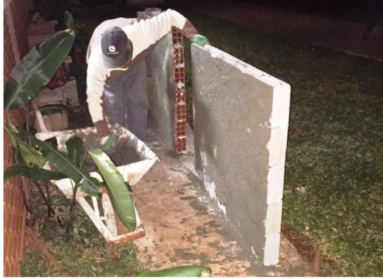
Figura 12 - Execução do chapisco lançado
