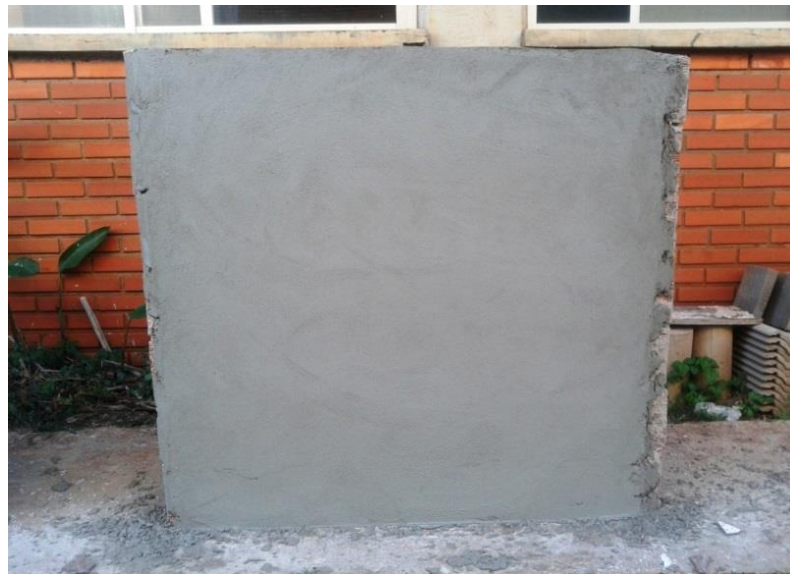
Figura 22 - Revestimento argamassado acabado
