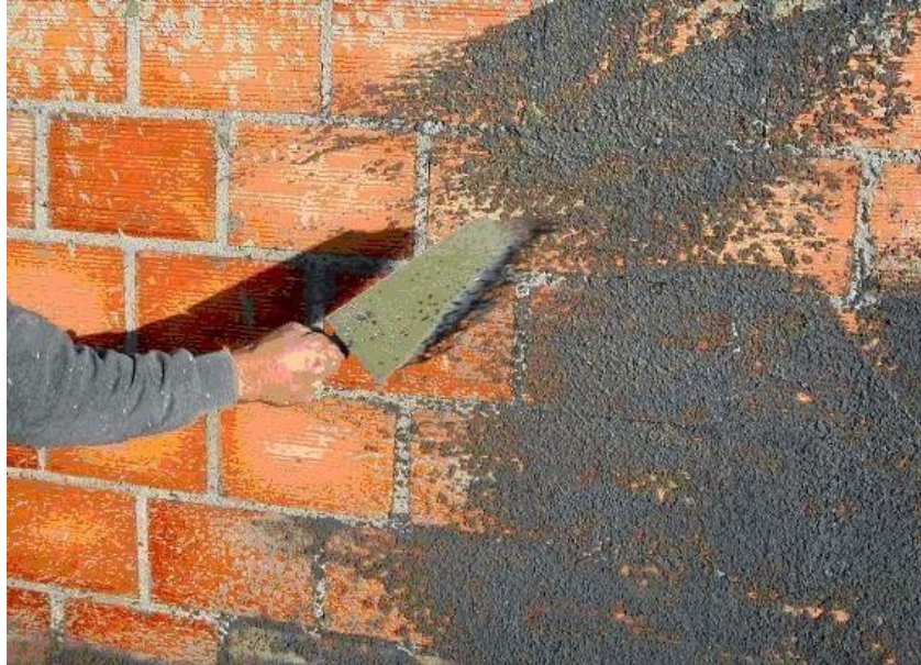
Figura 3 - Chapisco Convencional Fonte: Portal Brasil Engenharia
