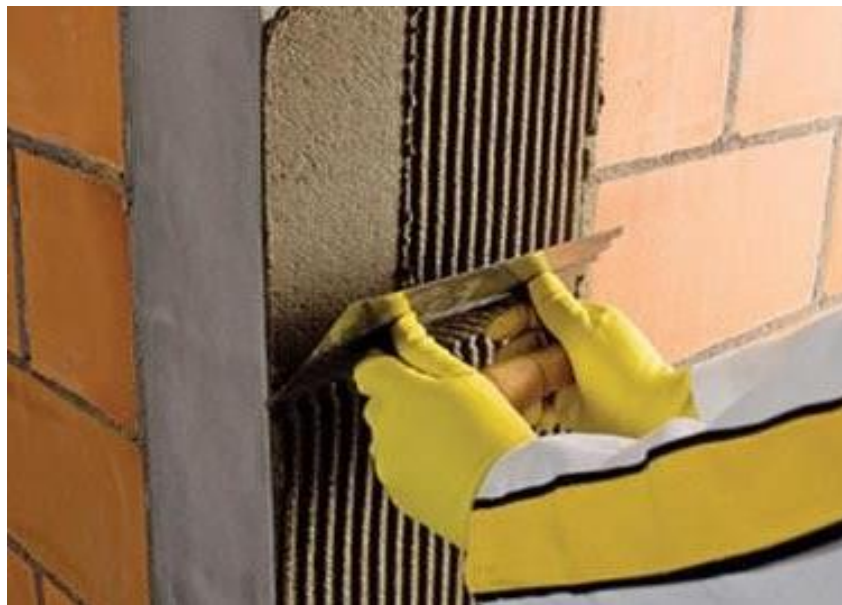
Figura 5 - Chapisco desempenado Fonte: Portal Brasil Engenharia
