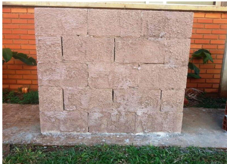
Figura 15 - Chapisco rolado sobre substrato de concreto (Lado B)
