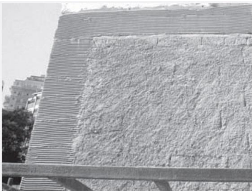
Figura 2 - Aplicação do chapisco em bases diferentes
