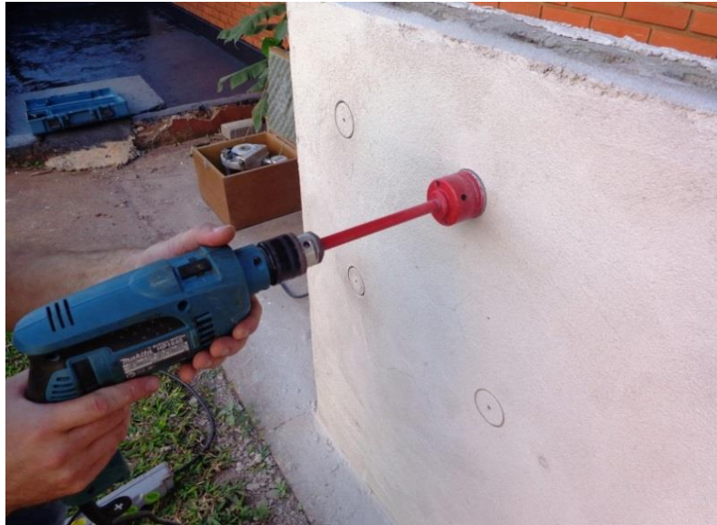
Figura 33 - Corte dos pontos de amostragem com a serra copo
