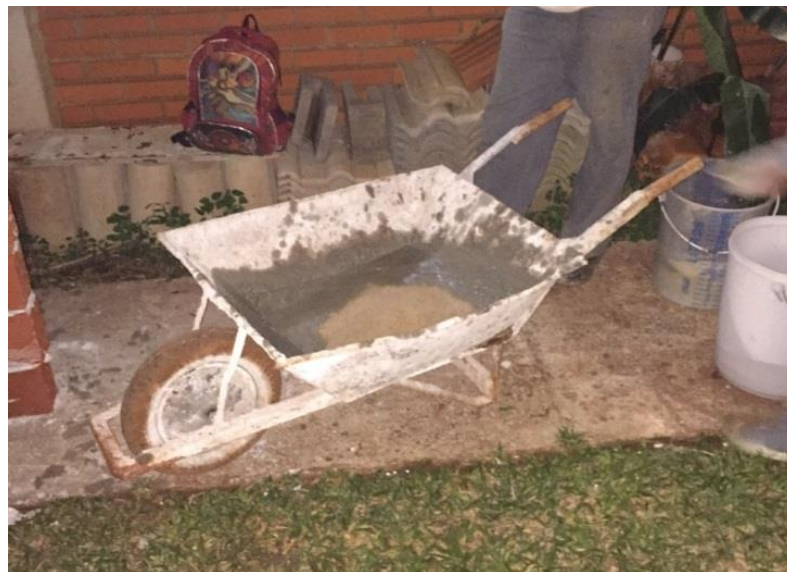
Figura 25 – Preparo manual da argamassa de chapisco lançado
