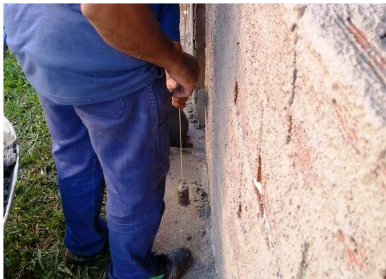
Figura 17 – Verificação do prumo
