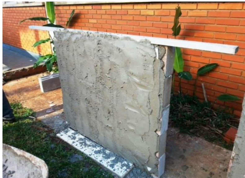
Figura 19 - Enchimento da camada de revestimento do protótipo
