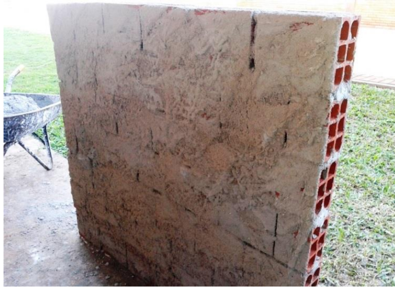
Figura 14 - Chapisco lançado sobre substrato cerâmico (Lado A)
