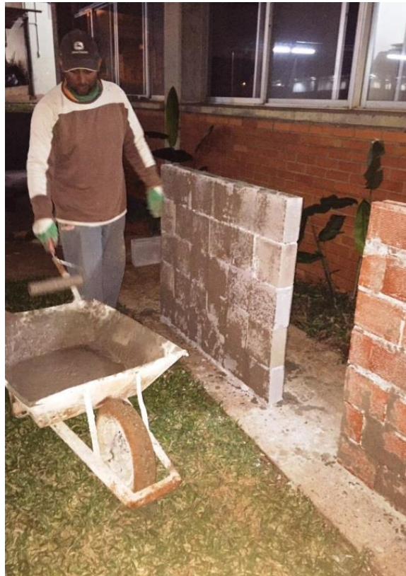
Figura 11 - Execução do chapisco rolado
