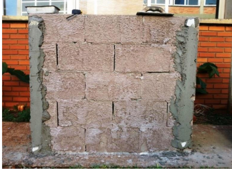
Figura 18 – Mestras para a regularização da superfície
