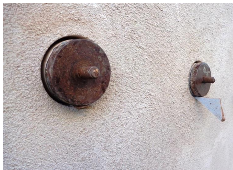
Figura 37 - Escoramento das pastilhas com palito de madeira e retalho cerâmico
