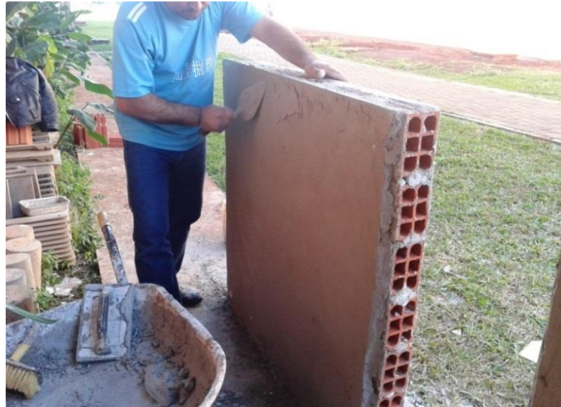
Figura 20 - Desempenamento e preenchimento de vazios da superfície do revestimento
