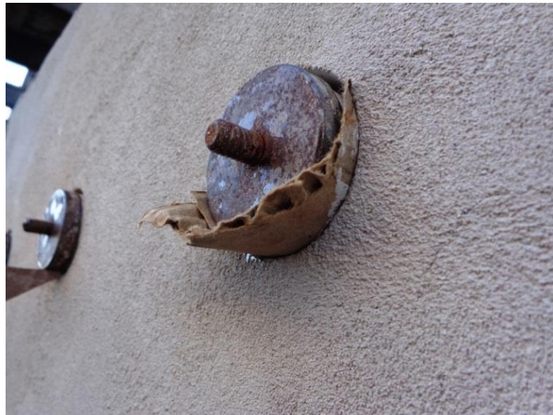
Figura 36 - Escoramento das pastilhas com papelão
