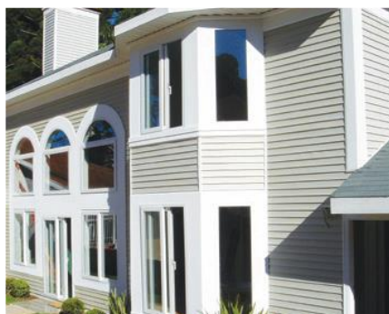
Figura 23: Revestimento externo em PVC
