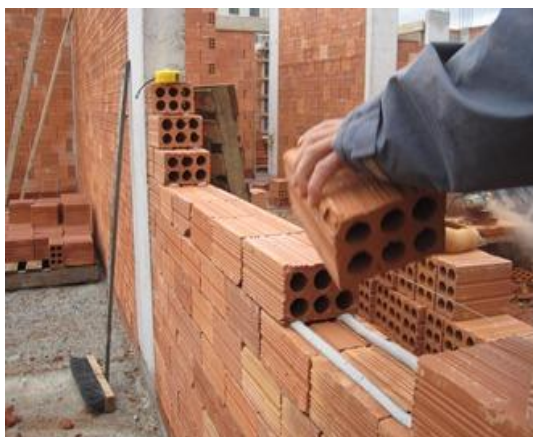
Figura 18: Assentamento com argamassa de Polímero. Fonte: Cerchiari, (2011)
