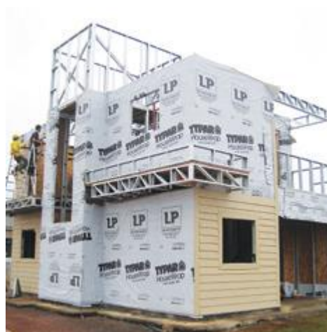
Figura 22: Aplicação de Membrana Hidrófuga.
