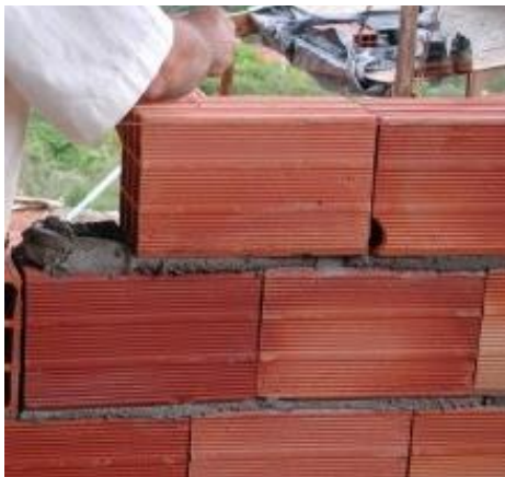
Figura 17: Assentamento com argamassa comum Fonte: Alvenaria de Tijolo (2011)
