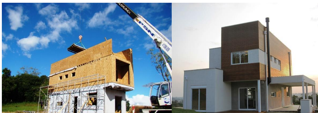
Figura 19: Casa de alto padrão em wood frame construída pela Tec verde®. Fonte: Cerchiari, (2013)
