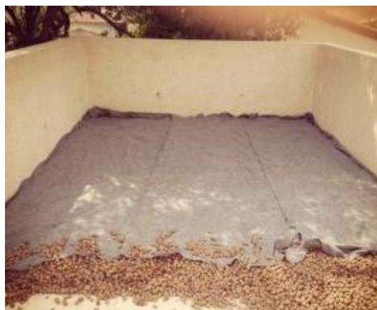
Figura 22 - Camada drenante já com a manta geotêxtil Fonte: Ecoeficiente (2013).
