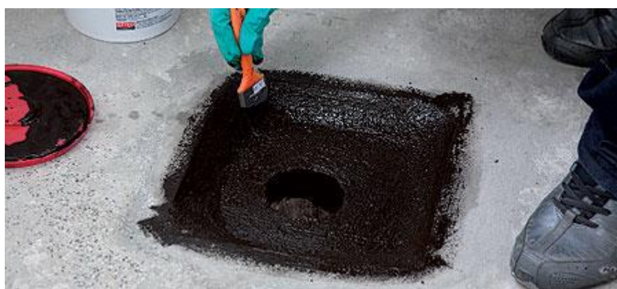
Figura 15 - Aplicação de primer no rebaixo do ralo Fonte: Pini (2010).
