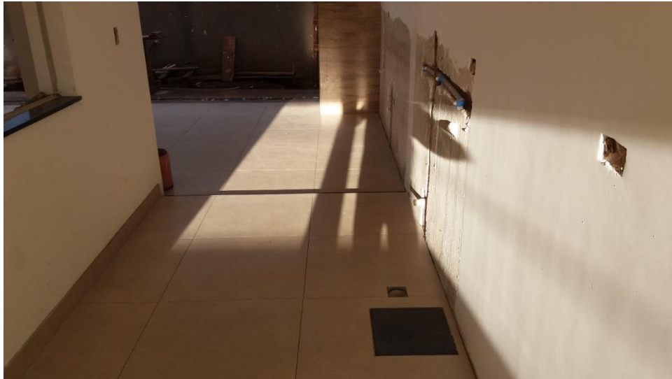
Fotografia 20 – Tubulação de água que abastece a lavanderia Fonte: Acervo de fotografias da obra.
