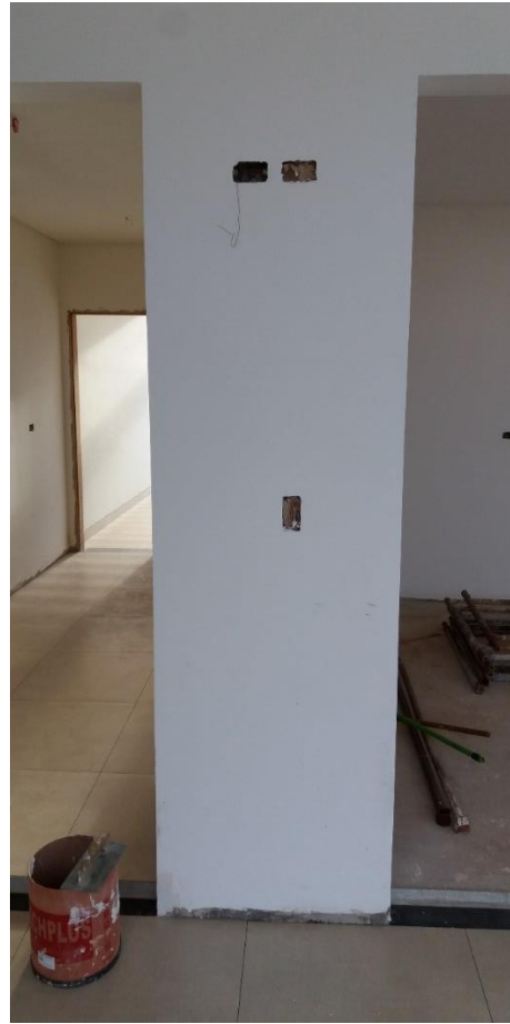
Fotografia 13 – Ponto de interruptor Fonte: Acervo de fotografias da obra.
