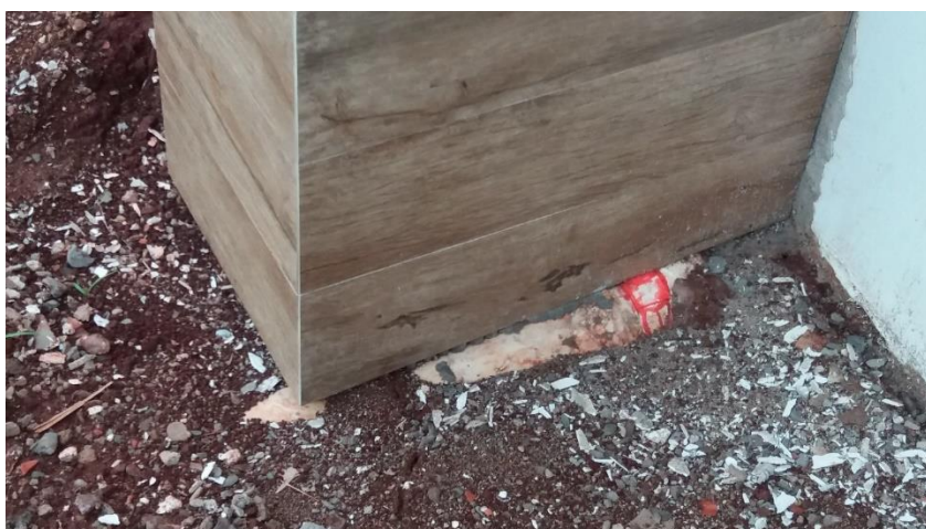
Fotografia 15 – Detalhe do shaft Fonte: Acervo de fotografias da obra.
