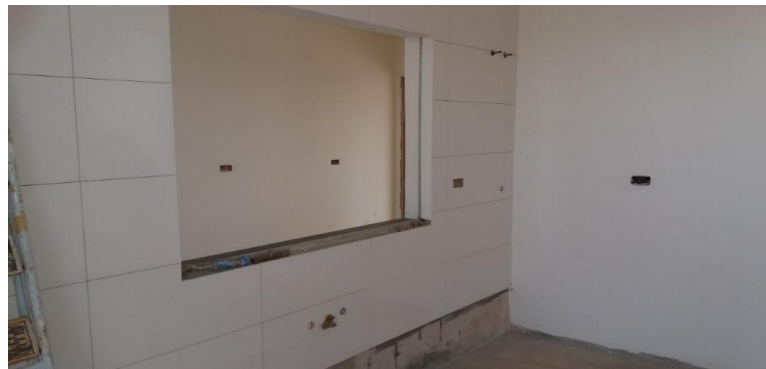
Fotografia 4 – Detalhe da tubulação de água da cozinha Fonte: Acervo de fotografias da obra.
