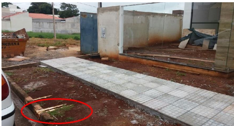
Fotografia 19 – Tubos de queda Fonte: Acervo de fotografias da obra.
