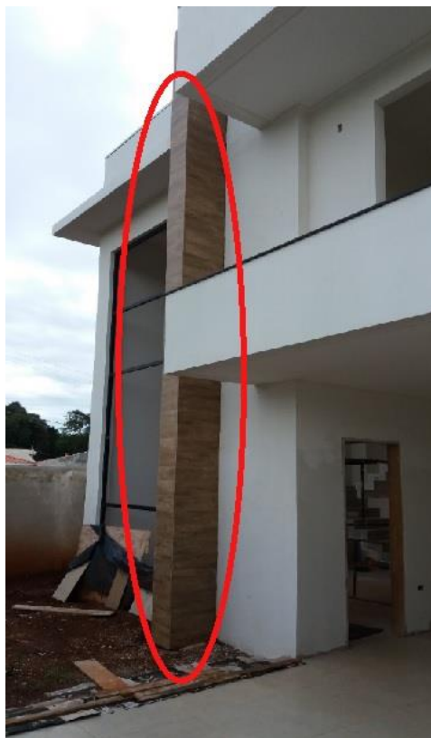
Fotografia 14 – Local da tubulação Fonte: Acervo de fotografias da obra.
