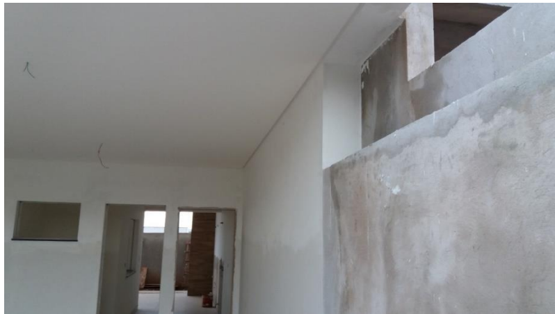
Fotografia 10 – Aumento da espessura das paredes da garagem Fonte: Acervo de fotografias da obra.
