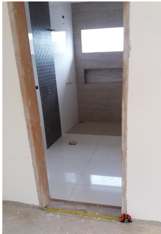
Fotografia 17 – Redução do vão da porta Fonte: Acervo de fotografias da obra.
