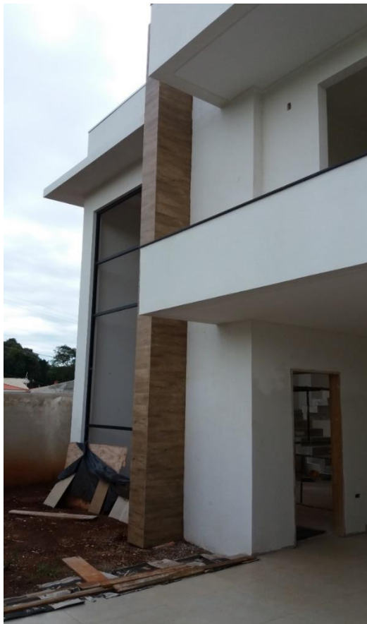
Fotografia 9 – Detalhe arquitetônico do pilar P15 Fonte: Acervo de fotografias da obra.
