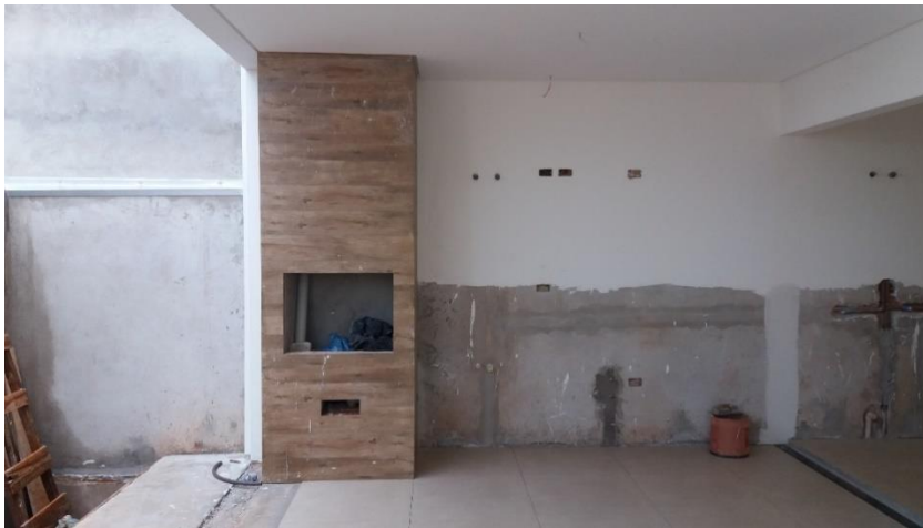
Fotografia 1 – Fotografia da churrasqueira executada Fonte: Acervo de fotografias da obra
