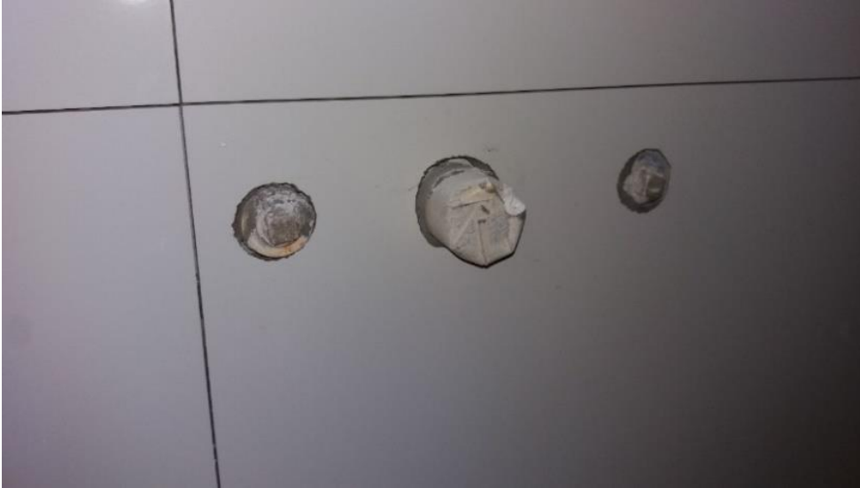
Fotografia 3 – Detalhe da tubulação de água do banheiro térreo Fonte: Acervo de fotografias da obra
