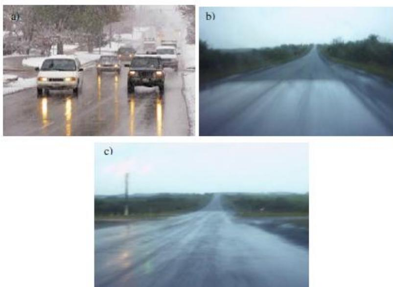
**Figura 7 – Escoamento de água e reflexão luminosa**
