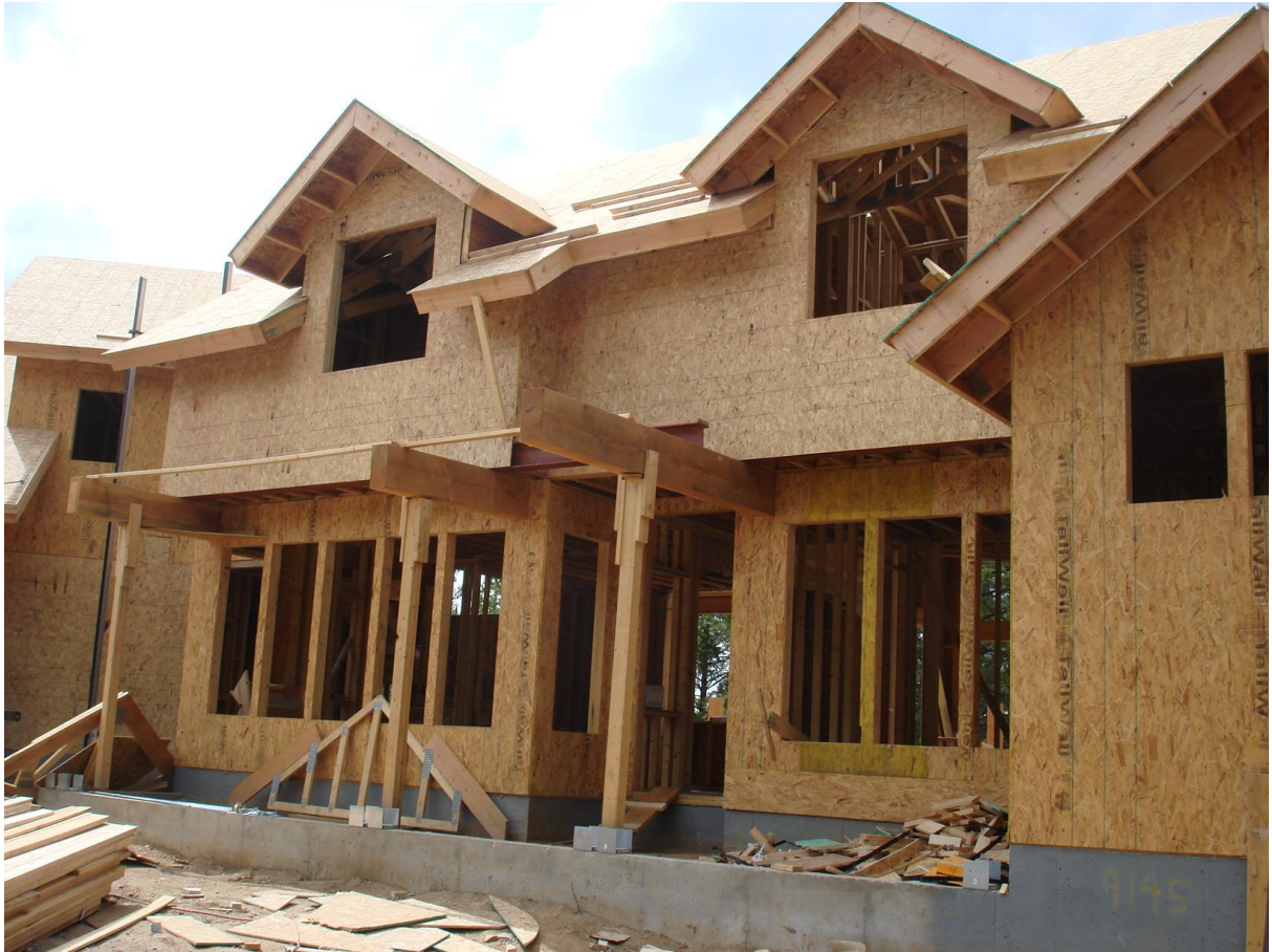
Figura 5 - Aplicação do OSB como elemento de parede Fonte: Bonde (2011)
