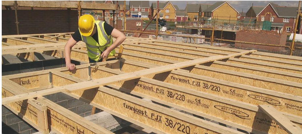
Figura 2 - Uso de vigas I-Joist como estrutura para pisos Fonte: Jular madeiras (2016)
