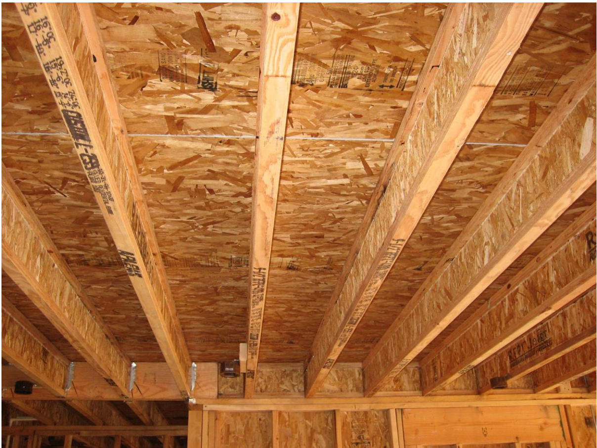
Figura 4 - Estrutura de piso com vigas I-Joist Fonte: XIII expoconstrucción expodiseño (2015)
