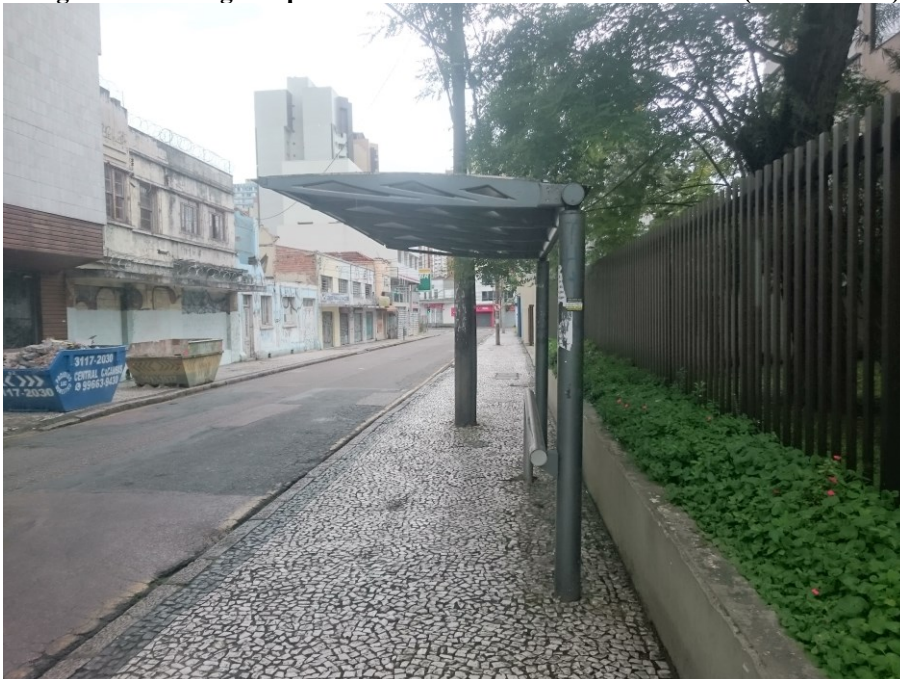
Fotografia 2 - Abrigo de parada de ônibus da cidade de Curitiba (Vista lateral).
