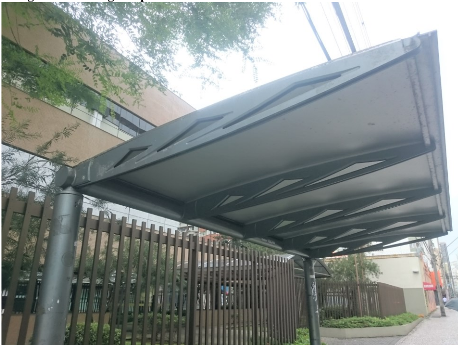
Fotografia 1 - Abrigo de parada de ônibus da cidade de Curitiba.
