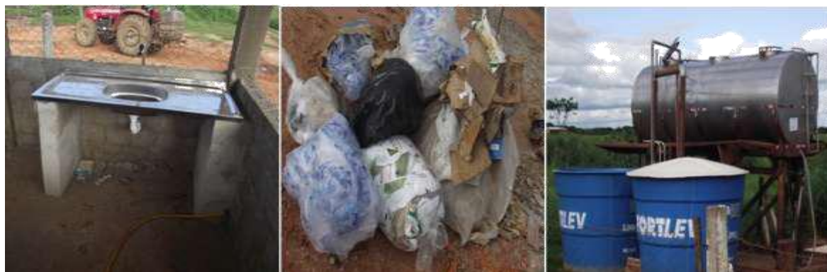
Figura 17. Sala de Resíduos e descarte de soro
