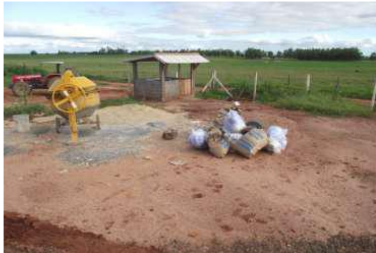
Figura 16. Resíduos de construção no pátio.
