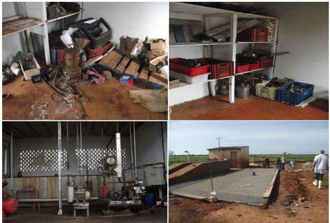
Figura 13. Oficina, sala de máquinas e pré-lavagem de caminhões.
