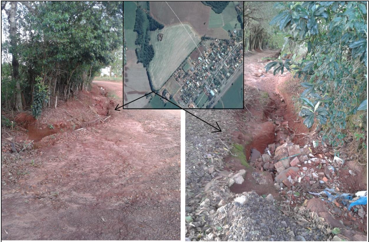
Figura 22: Ravina próxima de uma nascente em Piquirivaí-Pr. Fonte Santos, B. P., 2015.
