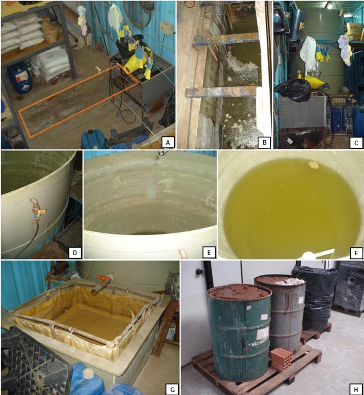
**Figura 14 – Tratamento de efluente líquido. A) Tampa do alçapão sobre o tanque de equalização; B) Tanque de equalização; C) Tanque de fibra onde o efluente é tratado; D) e E) Dosador de produtos químicos; F) Vista superior do tanque de tratamento de efluente; G) Filtro do lodo; H) Armazenamento do lodo galvânico.**
