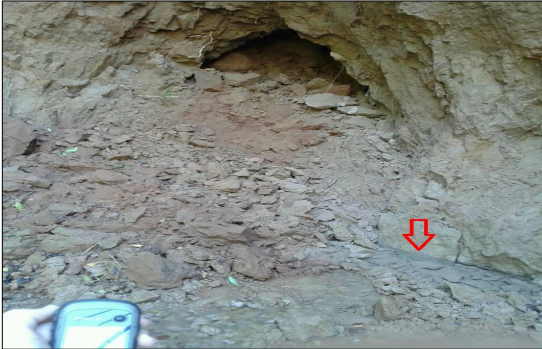
Figura 18 – Indicação do afloramento do lençol freático na área de voçoroca no parque em Goioerê - PR.
