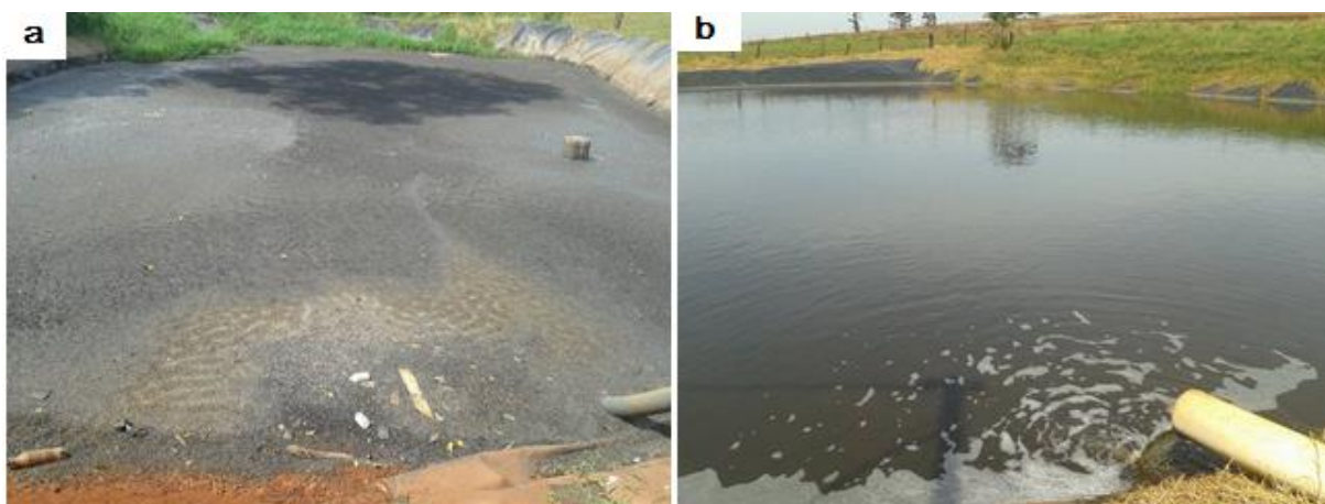
Figura 3 – Vista frontal da (a) esterqueira e da (b) lagoa de polimento, ilustrando o início e o fim do tratamento das águas residuárias da granja estudada.
