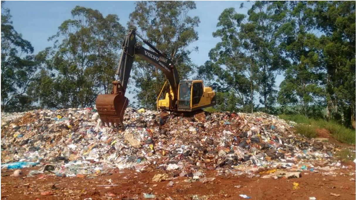
Figura 10 - Situação atual do aterro do Município de Mandaguaçu – PR
