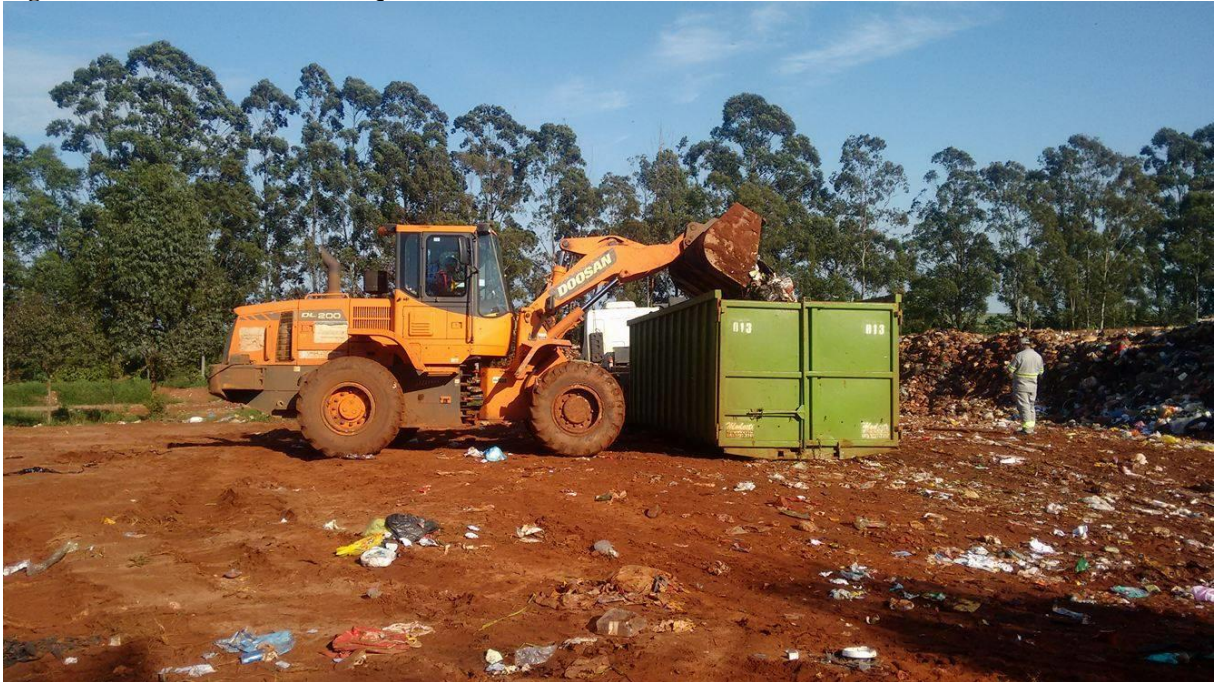
Figura 12 - Retirada do resíduo que estava acima do limite da vala
