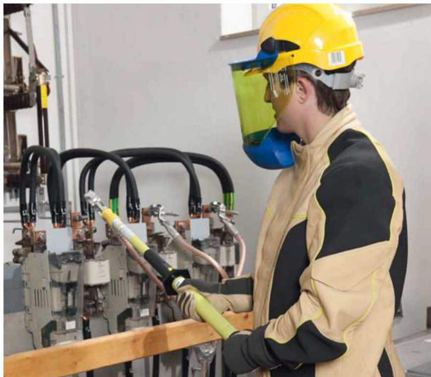
Figura 5 - Profissional paramentado com EPIs para proteção contra arco elétrico
