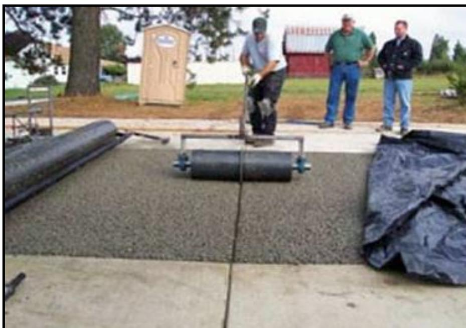
**Figura 5- Representação do rolo com aresta cortante que divide a pavimentação de Concreto Permeável, contribuindo assim com reparos e manutenção da via.
