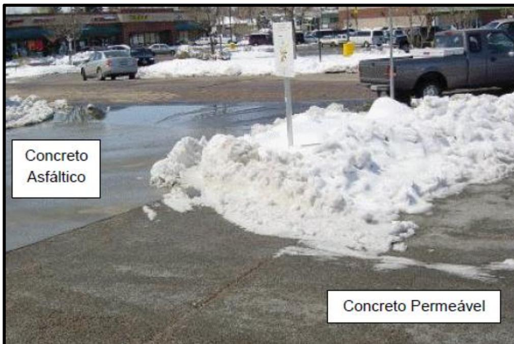
**Figura 2- Ilustração da pavimentação por asfalto comum impermeável onde notasse o acúmulo de água e pavimentação por concreto permeável.
