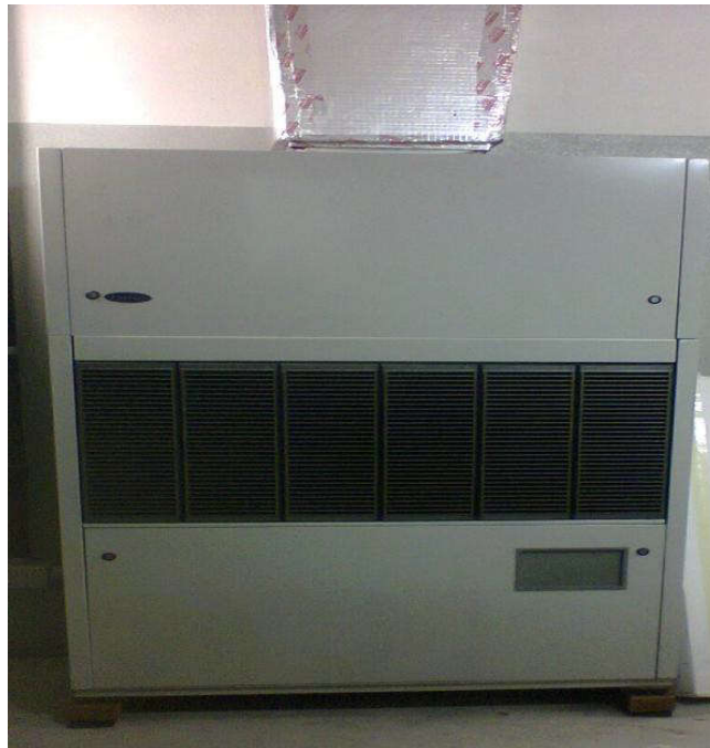
Fotografia 1 - Máquina de ar condicionado (31kW, 99A)
