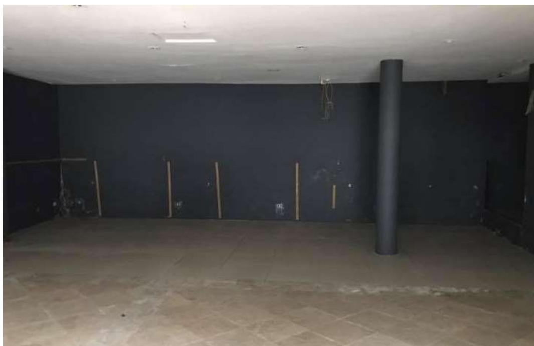
Figura 27 – Parte de trás do salão Fonte: Autoria própria, 2017
